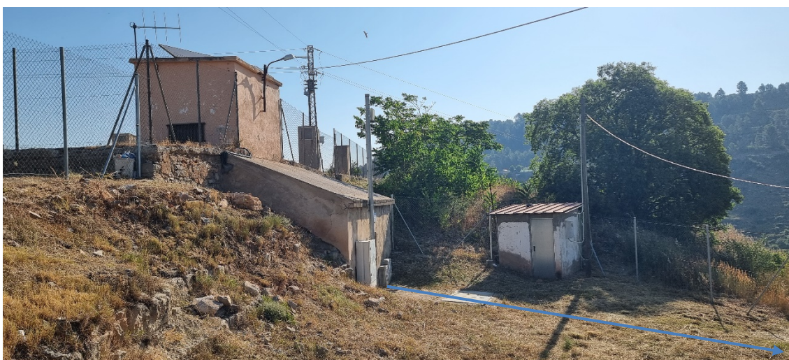
Imatge del punt on es farà la nova connexió al dipòsit de Pal
