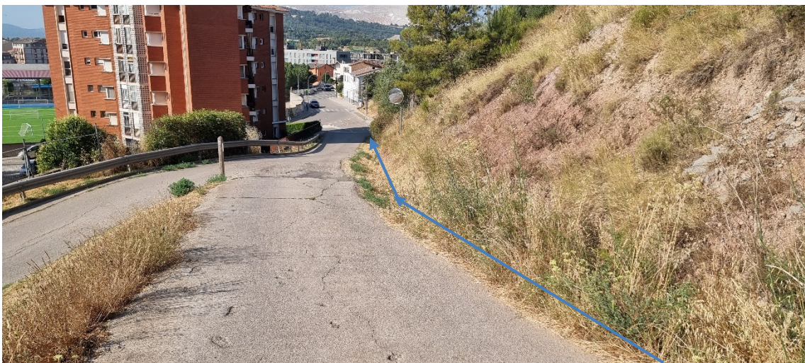
Imatge del tram de cuneta de formigó
