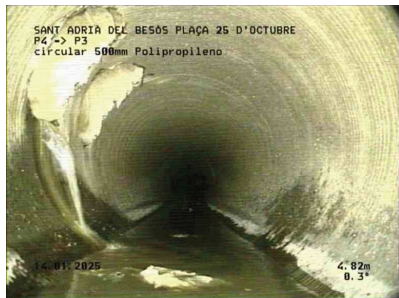
42-SANT ADRIÀ DEL BESÒS-PLAÇA 25 D'OCTUBREP3P4.jpg, 00:00:43, 4.82m Unión, conexión abierta,, altura: 81mm, anchura: 81mm a 10 Reloj
