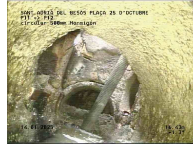
25-SANT ADRIÀ DEL BESÒS-PLAÇA 25 D'OCTUBREP11P12.jpg, 00:07:56, 16.43m Unión, conexión abierta, altura: 81mm, anchura: 81mm a 9 Reloj
