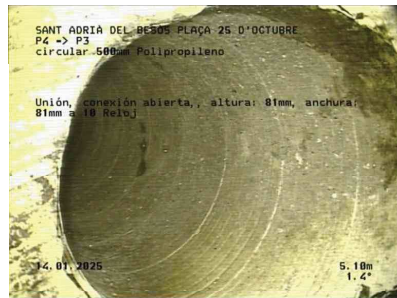
43-SANT ADRIÀ DEL BESÒS-PLAÇA 25 D'OCTUBREP3P4.jpg, 00:01:17, 5.10m Unión, conexión abierta,, altura: 81mm, anchura: 81mm a 10 Reloj
