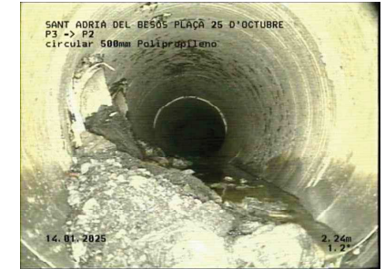
51-SANT ADRIÀ DEL BESÒS-PLAÇA 25 D'OCTUBRE P3P2.jpg, 00:00:23, 2.24m Depósitos áridos gruesos (por ejemplo cascotes, gravar) en el hilo, grueso, 30%
