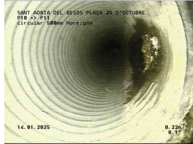
20-SANT ADRIÀ DEL BESÒS-PLAÇA 25 D'OCTUBRE D'OCTUBRE10P11.jpg, 00:01:26, 0.22m Unión, conexión abierta., altura: 81mm, anchura: 81mm a 3 Reloj
