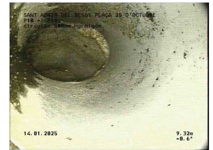
27-SANT ADRIÀ DEL BESÒS-PLAÇA 25 D'OCTUBRE D'OCTUBRE10P11.jpg, 00:04:09, 9.31m Unión, conexión abierta., altura: 81mm, anchura: 81mm a 9 Reloj
