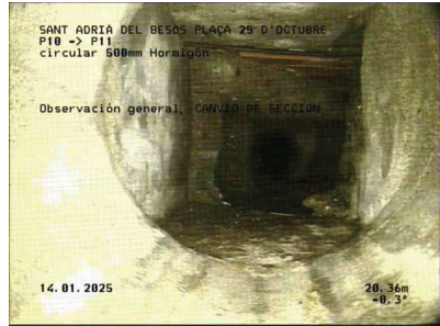
35-SANT ADRIÀ DEL BESÒS-PLAÇA 25 D'OCTUBRE P10P11.jpg, 00:08:12, 20.36m Observación general / CANVIO DE SECCION
