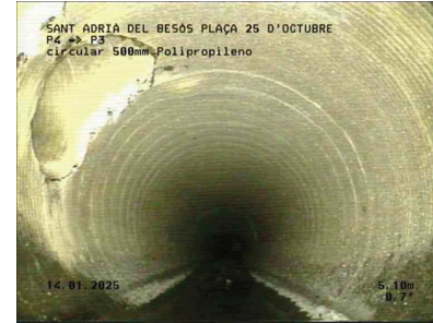
44-SANT ADRIÀ DEL BESÒS-PLAÇA 25 D'OCTUBREP3P4.jpg, 00:01:17, 5.10m Unión, conexión abierta,, altura: 81mm, anchura: 81mm a 10 Reloj
