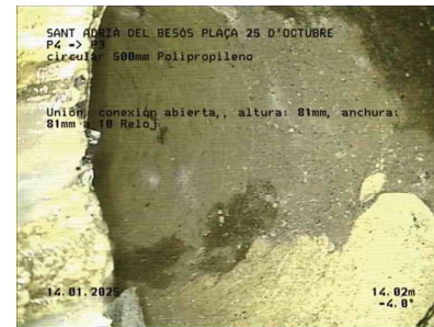
46-SANT ADRIÀ DEL BESÒS-PLAÇA 25 D'OCTUBREP3P4.jpg, 00:02:40, 14.02m Unión, conexión abierta,, altura: 81mm, anchura: 81mm a 10 Reloj
