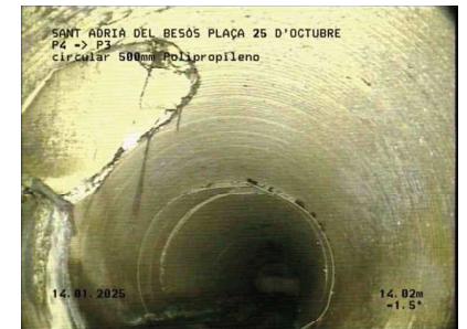
47-SANT ADRIÀ DEL BESÒS-PLAÇA 25 D'OCTUBREP3P4.jpg, 00:02:40, 14.02m Unión, conexión abierta,, altura: 81mm, anchura: 81mm a 10 Reloj
