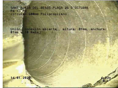
41-SANT ADRIÀ DEL BESÒS-PLAÇA 25 D'OCTUBREP3P4.jpg, 00:00:43, 4.82m Unión, conexión abierta,, altura: 81mm, anchura: 81mm a 10 Reloj
