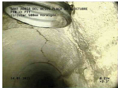
21-SANT ADRIÀ DEL BESÒS-PLAÇA 25 D'OCTUBRE D'OCTUBRE10P11.jpg, 00:01:26, 0.22m Unión, conexión abierta., altura: 81mm, anchura: 81mm a 3 Reloj
