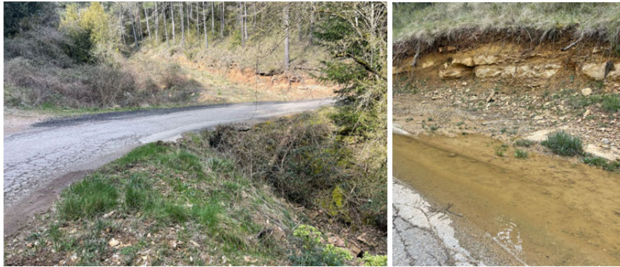
Figures 19 i 20: Imatges de l'estat actual del gual inundable a formigonar.
