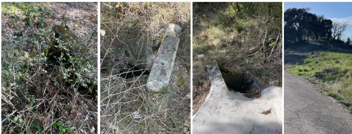
Figures 15, 16, 17 i 18: Imatges de l'estat actual de les canadelles.
