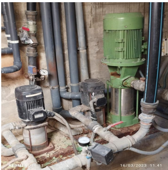
Bomba vertical del reg de la pista d'atletisme
