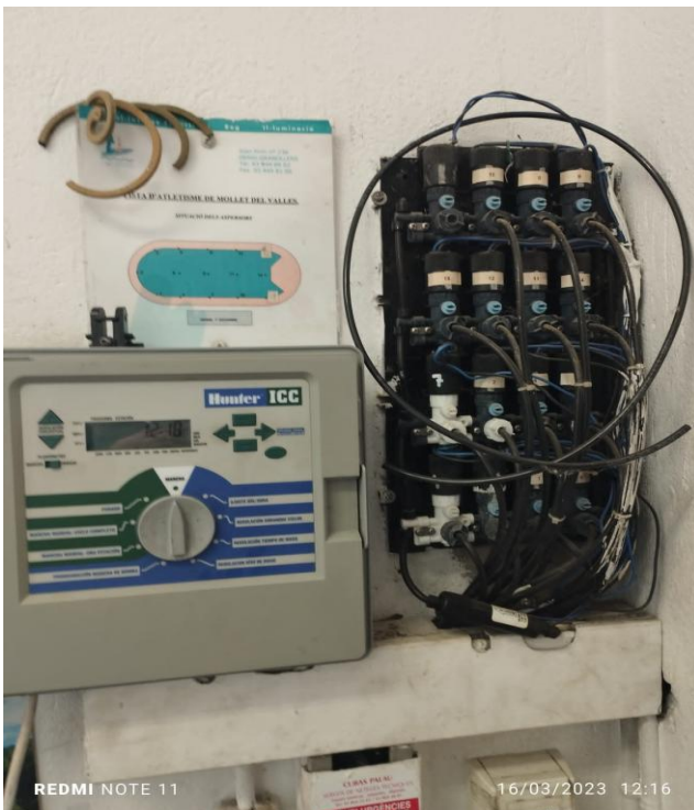
Programador Hunter i electrovàlvules a consergeria.
