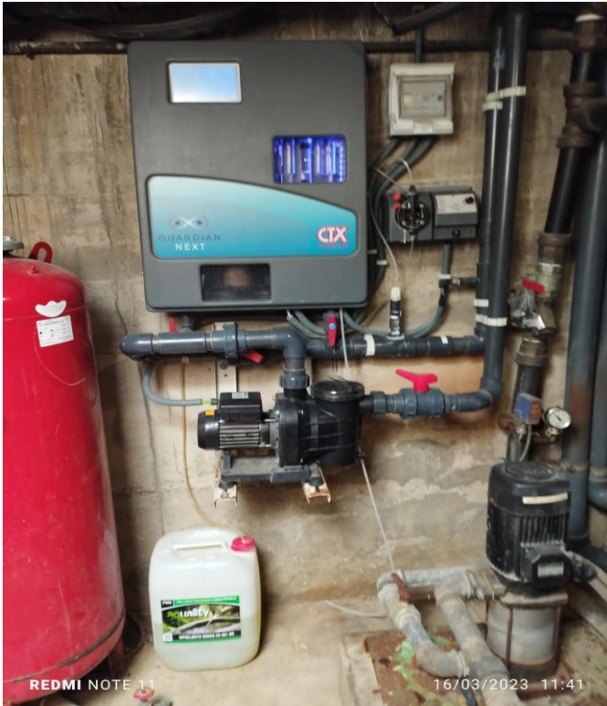
Bomba sistema cloració
