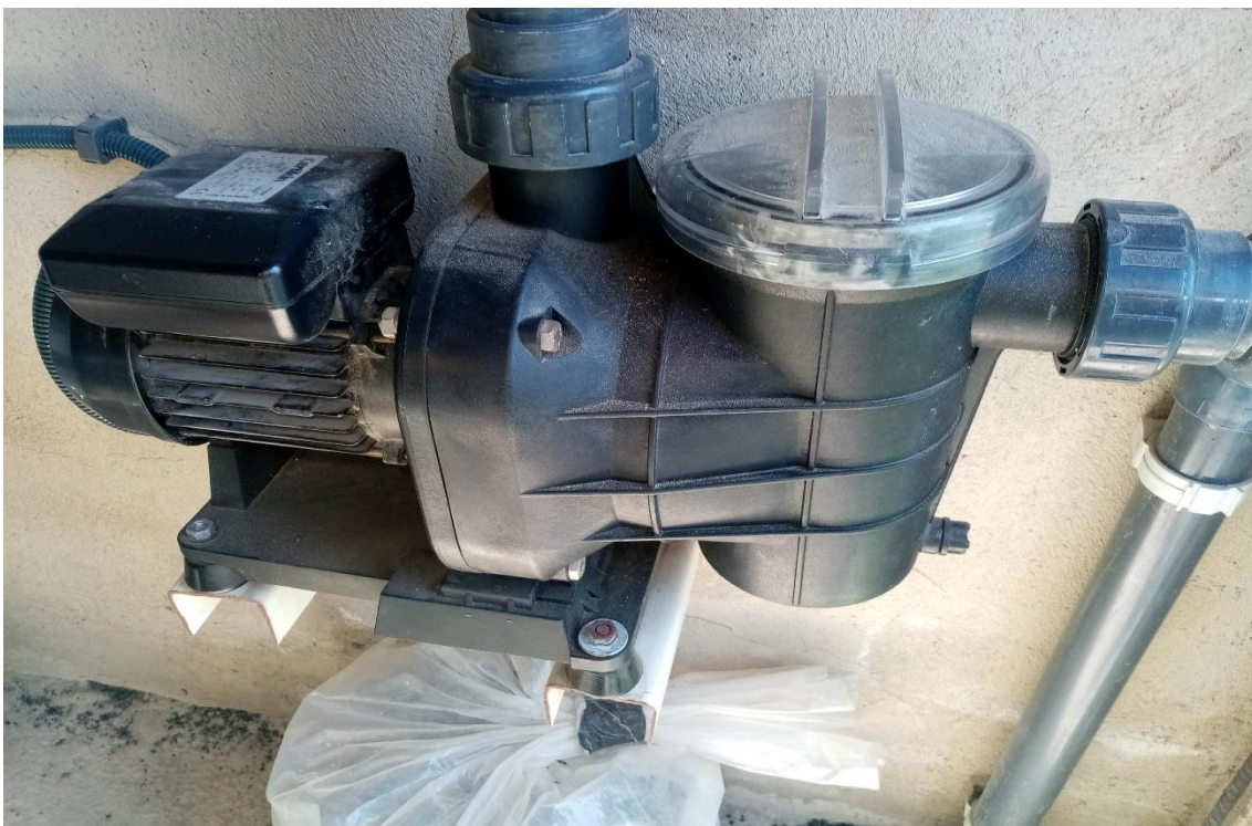
Bomba del sistema de cloració
