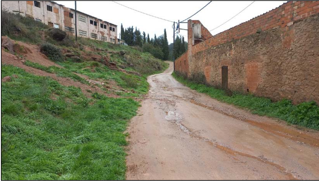
Imatge 8. Tram inferior, en entrega amb el carrer Barcelona, en el que es pretén pavimentar 3 metres d'amplada i col·locar l'embornal per la recollida d'aigua.
