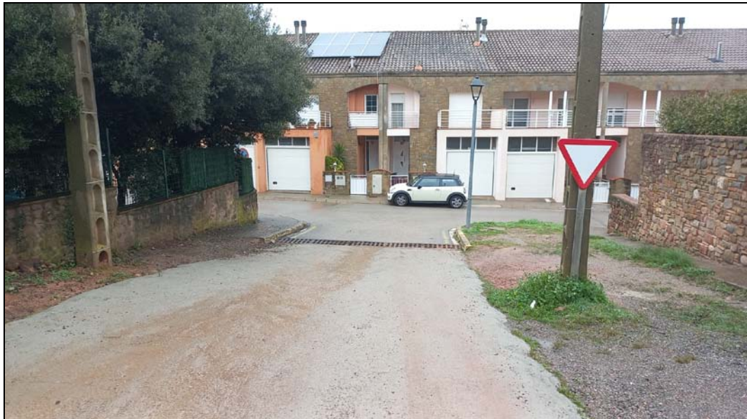
Imatge 3. Tram de paviment a realitzar la demolició.
