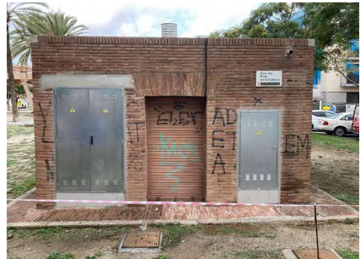
V8. Antiga construcció ara recinte de quadres elèctrics.
