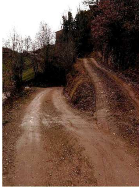
Imatge 3. Estat actual de l'àmbit d'actuació
