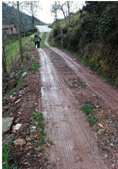
Imatge 4. Estat actual de l'àmbit d'actuació
