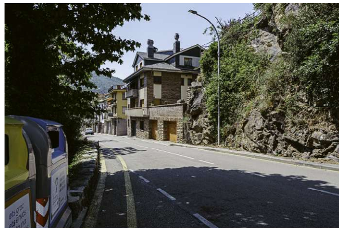
Carretera de Queralbs. Àmbit de construcció de reductor de velocitat.
