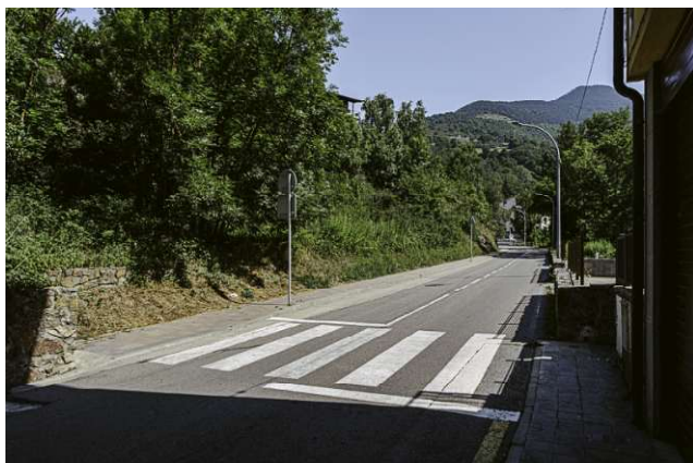
Construcció d'un reductor de velocitat tipus esquena d'ase, després del pas de vianants.
