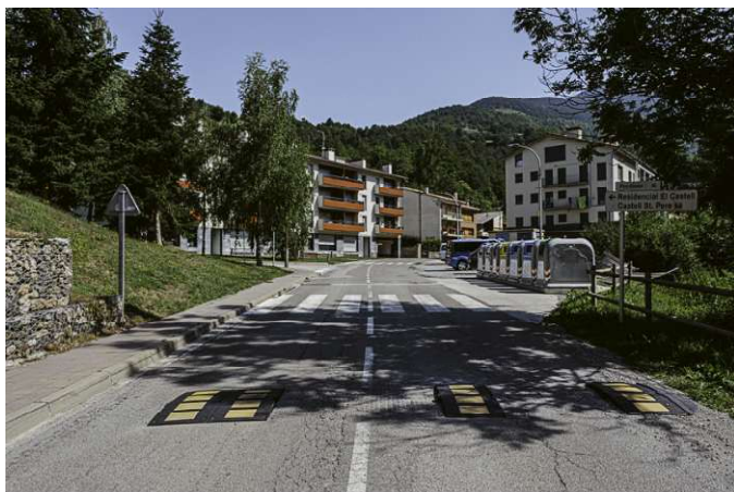
Reductor de velocitat prefabricat en mal estat a desmuntar.
