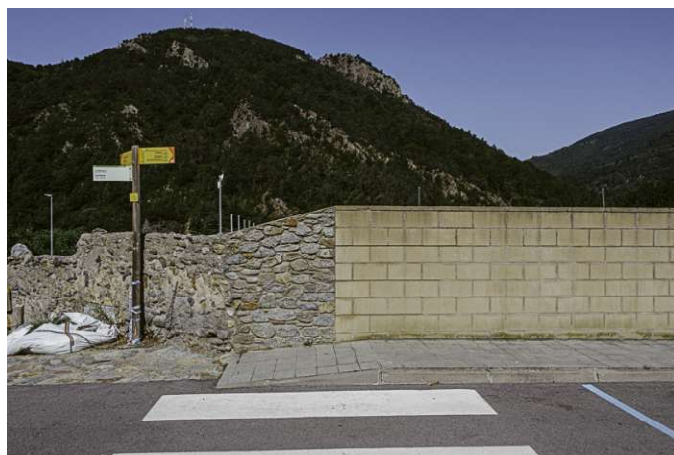
Vorera oest i paviment de pedra a modificar.
