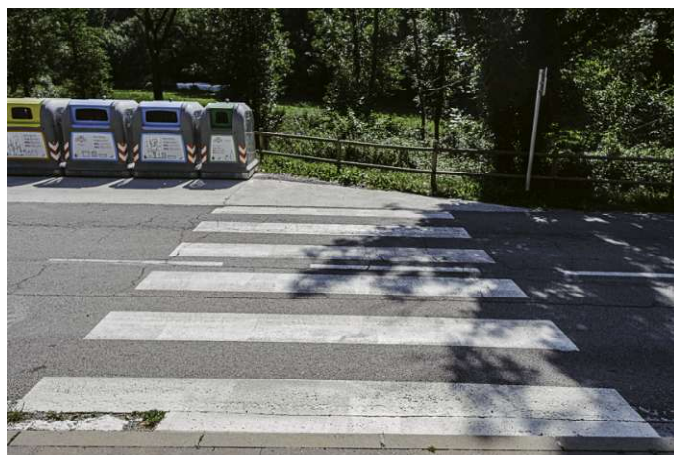
Plataforma a construir a l'altra banda i contenidors a desplaçar.
