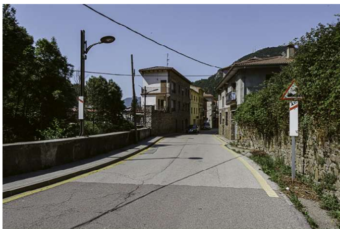
Àmbit de construcció d'un reductor de velocitat tipus esquena d'ase.
