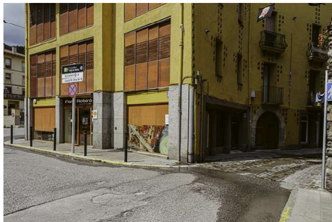
Aigua entrant des de la N-260 al carrer major
