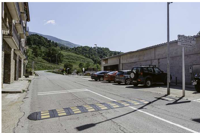
Reductor de velocitat prefabricat a la sortida direcció pardines a desmuntar.
