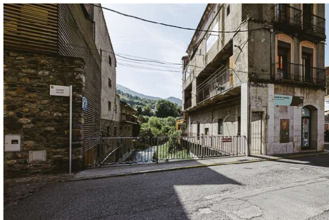
Entrada carrer major, sobre el riu Rigard.
