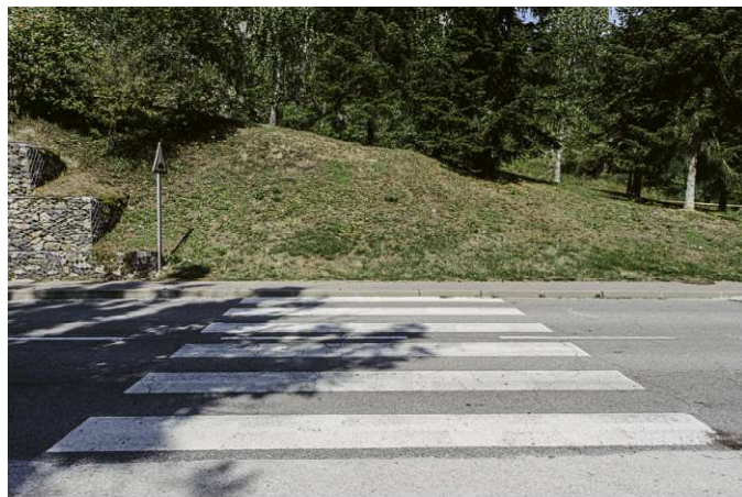
Pas de vianants a la carretera de Pardines a elevar.
