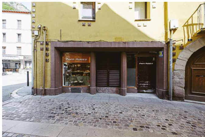
Entrada del carrer major, entrada local comercial.
