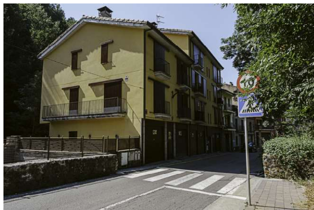
Construcció d'un reductor de velocitat tipus esquena d'ase, abans del pas de vianants.
