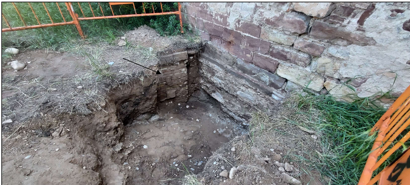
Foto nº 2: Detall de la cala feta en zona del S-4/P-2/S4bis. La fletxa indica la paret de totxana annex a la façana de l'edifici.
