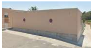
Central de producció de fred i calor
