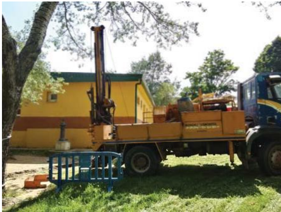
Emplaçament i màquina utilitzada en DPSH P-01.
