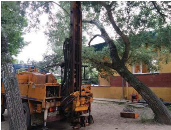
Emplaçament i màquina utilitzada en sondeig S-01.
