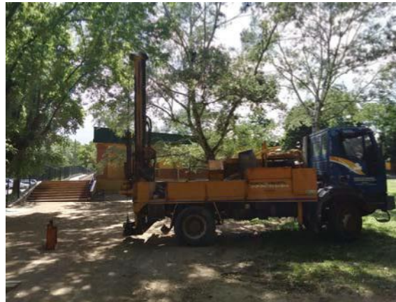
Emplaçament i màquina utilitzada en DPSH P-02.
