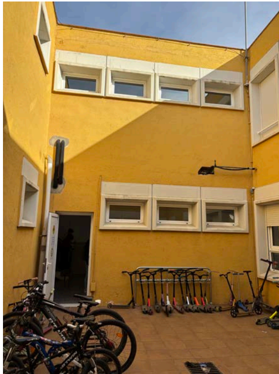
ZONA D'ACTUACIÓ 1 - Ascensor
