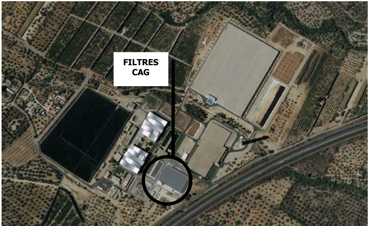
Imatge de l'ETAP Ampolla amb el detall de la nau dels filtres de carbó granular
