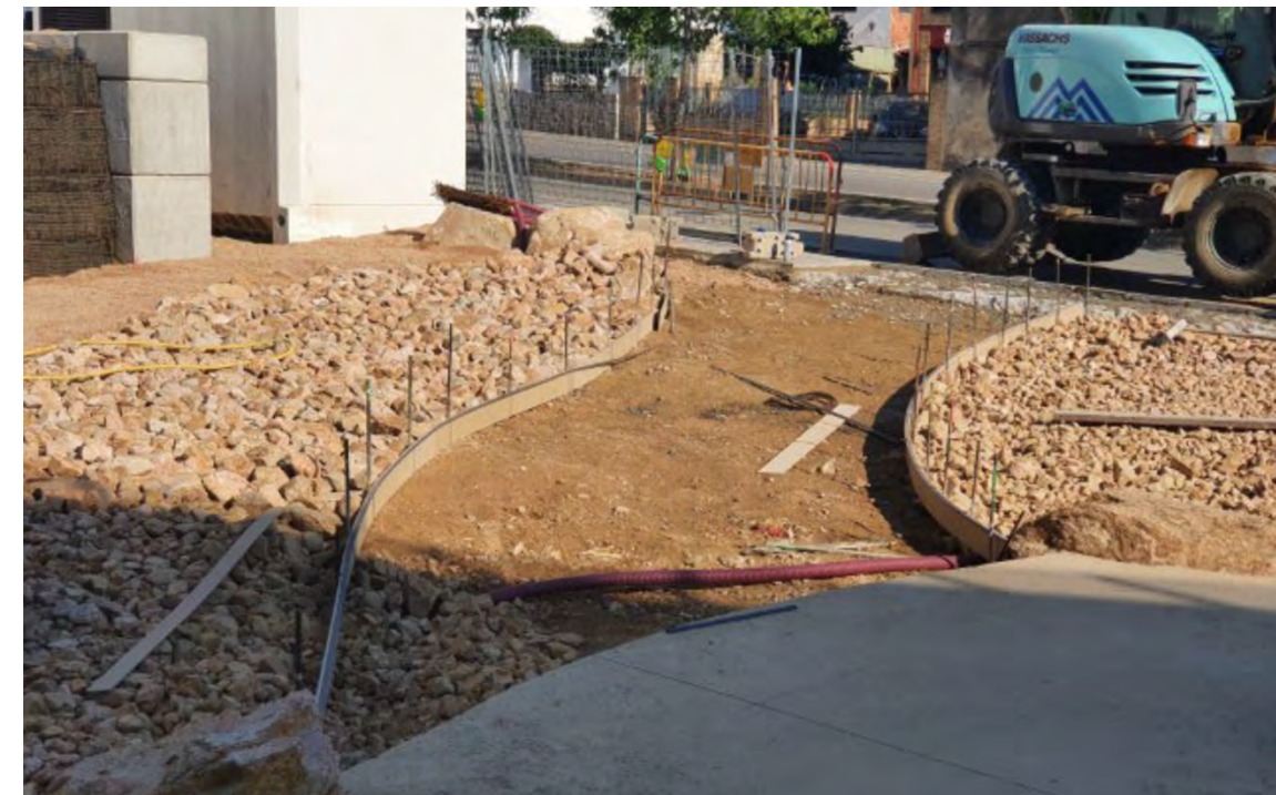
Exemples d'ús de l'encofrat flexible
