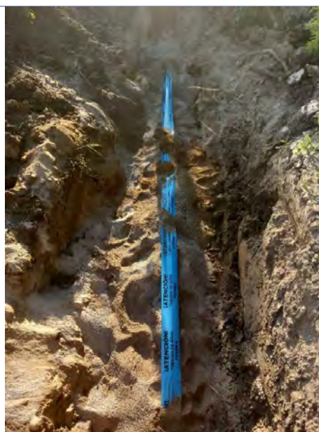
Figura 7: Rasa tram nord, sorra vermella i cinta senyalitzadora d'aigua potable
