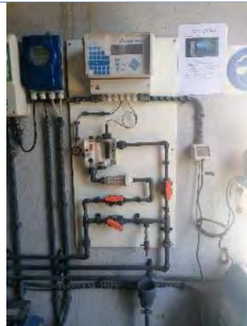
Figura 17: Mural de clor del dipòsit de Serrabonica
