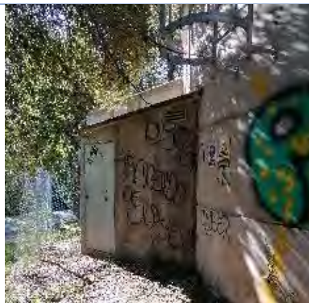
Figura 14: Caseta del dispensador de Clor del dipòsit de Vespella
