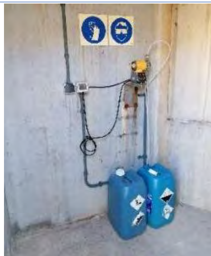
Figura 11: Clor del dipòsit de Cap del Pla
