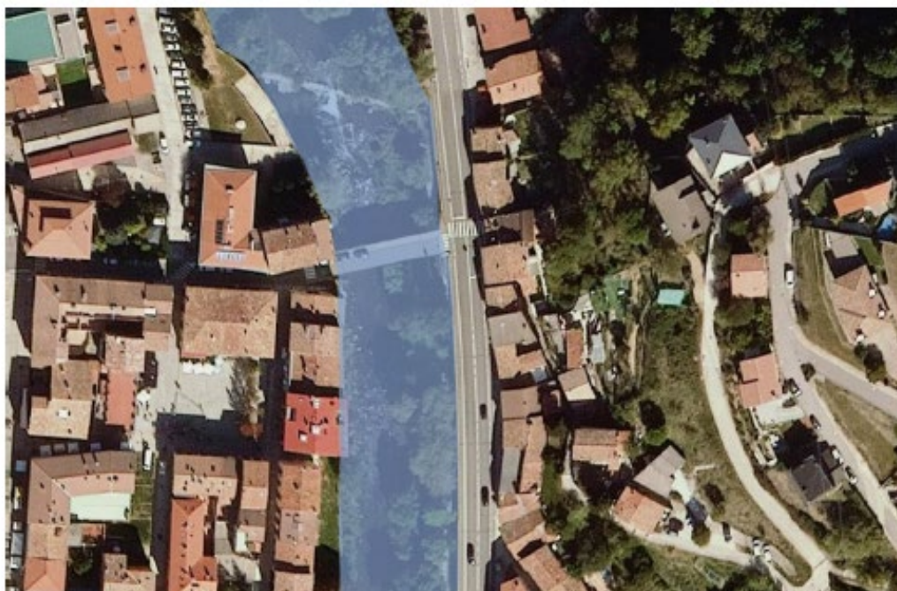
DPH del riu Freser en l'àmbit de l'obra
