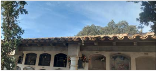
REPARACIÓ PUNTUAL DE COBERTES
