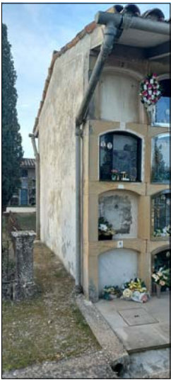
CANALS I BAIXANTS DE FIBROCIMENT EXISTENT
