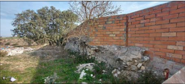
MUR PERIMETRAL DE RECINTE EXISTENT
