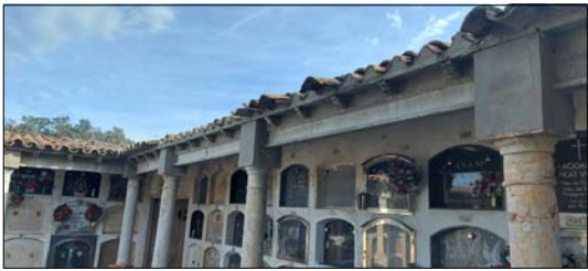
REPARACIÓ PUNTUAL DE COBERTES
