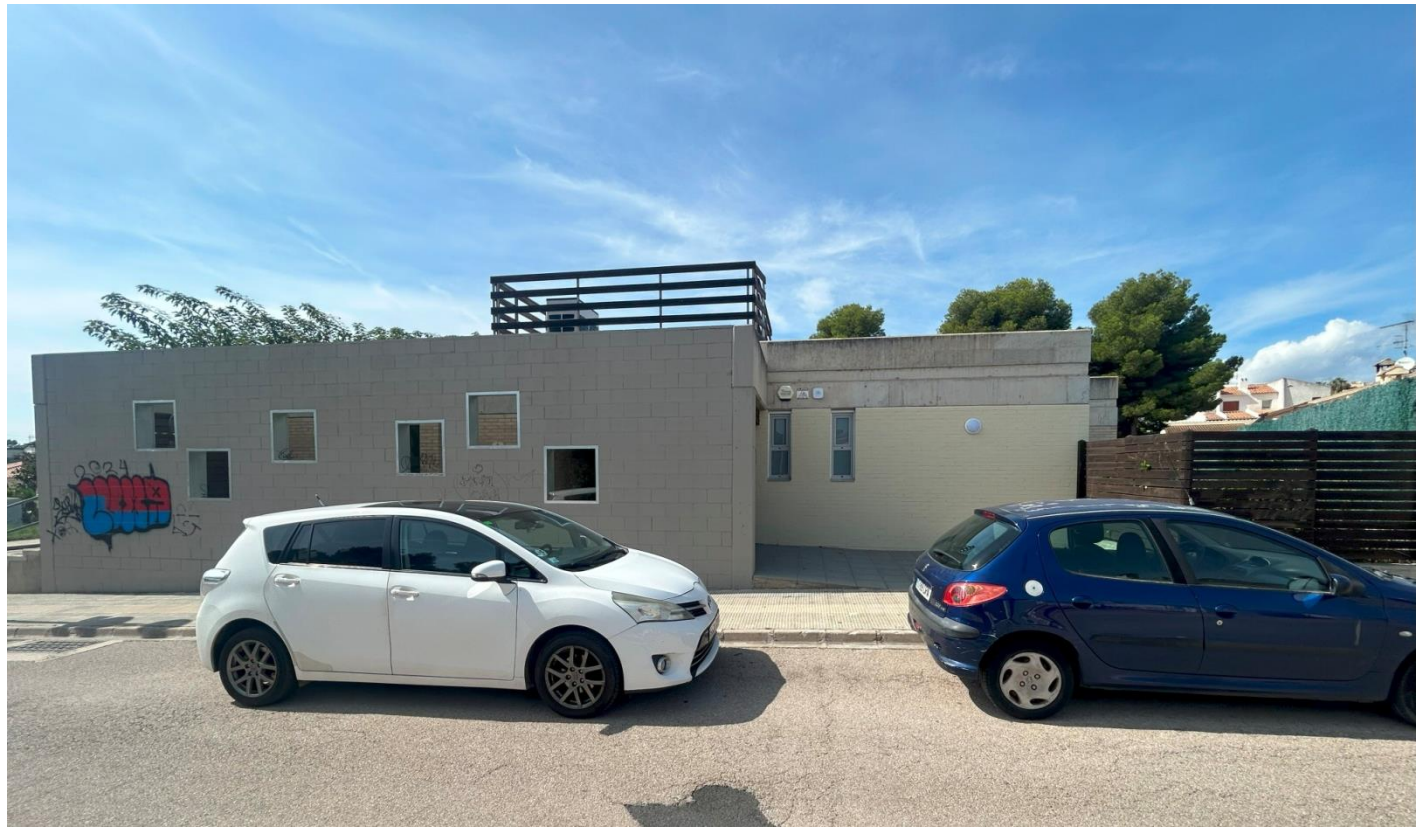
Fotografia façana lateral
