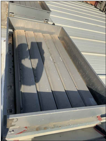
IMG 03. Vista superior de exutori amb lamel·les motoritzades
