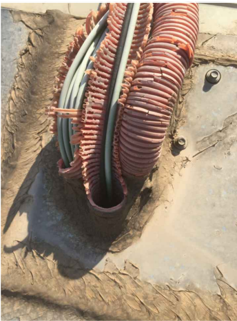
IMG 10. Tubs d'instal·lacions a segellar
