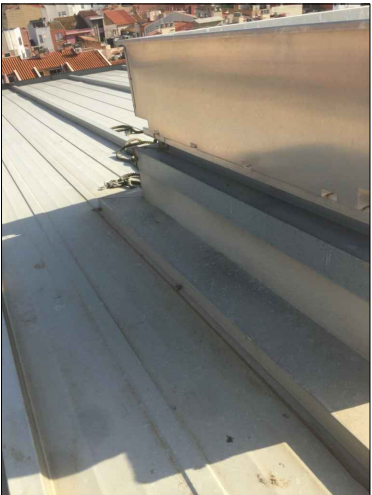
IMG 06. Vista lateral en la pendent de la coberta
