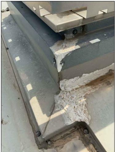
IMG 05. Vista de cantonada exutori amb multiples segellats a extreure
