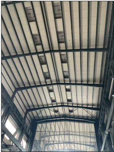
IMG G1. Imatge general per l'interior de la nau de la coberta inclinada amb els exutoris motoritzats
