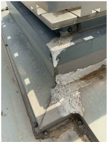
IMG 09. Juntes element exutori degradades
