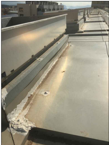
IMG 04. Vista lateral exutori. Segellats a extreure.
