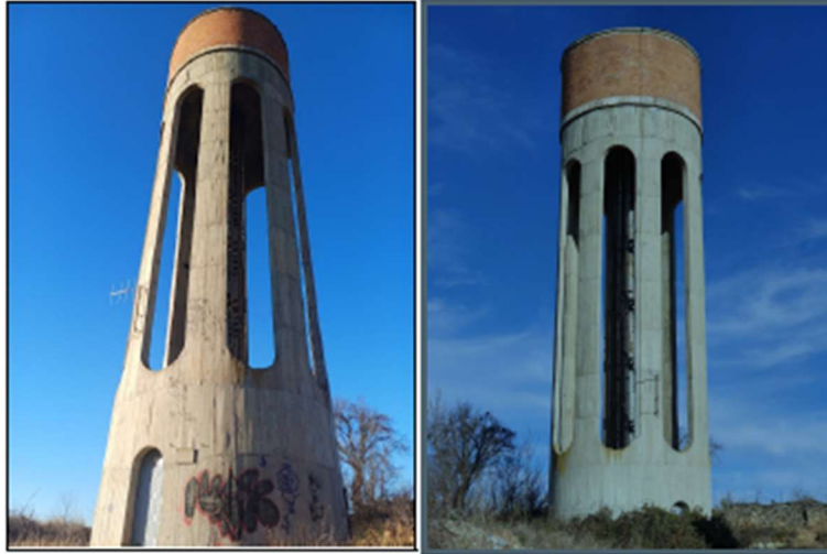
1. Dipòsit elevat d'El Talladell (fora d'ús)
