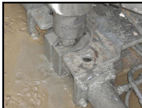
Detalle inyección de lechada.
