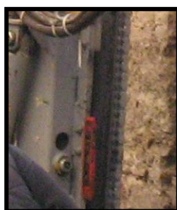
Nivelación del mástil mediante nivel magnético
