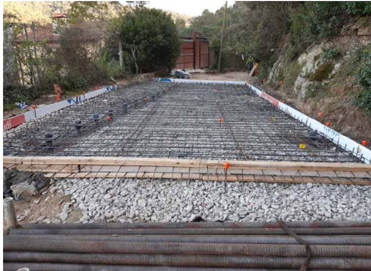
Execució micros i llosa estructural
