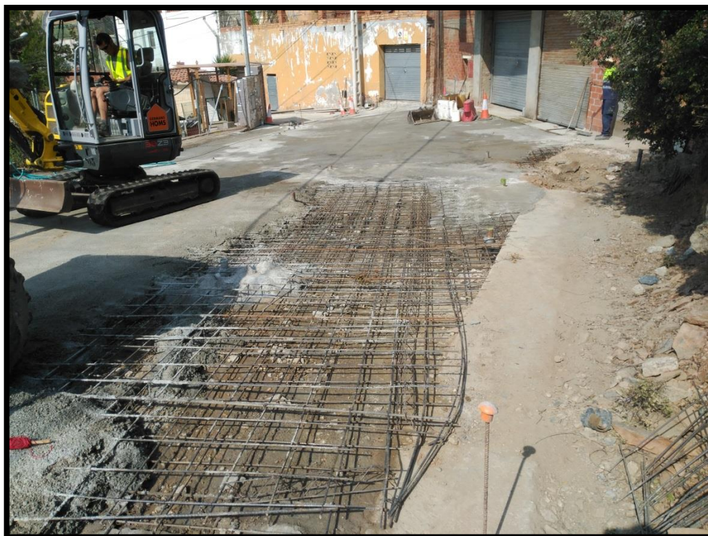
Losa conectada a los micropilotes mediante la cabeza homologada.
