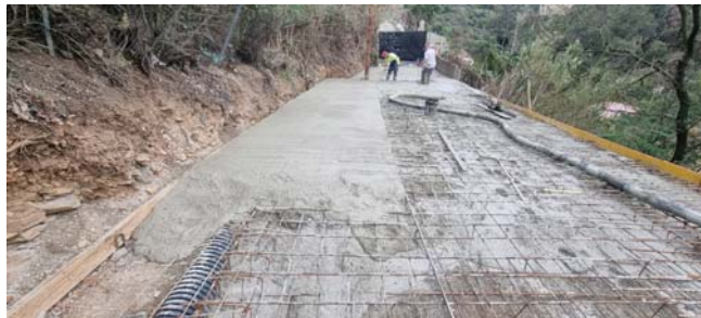
Fase execució obra
