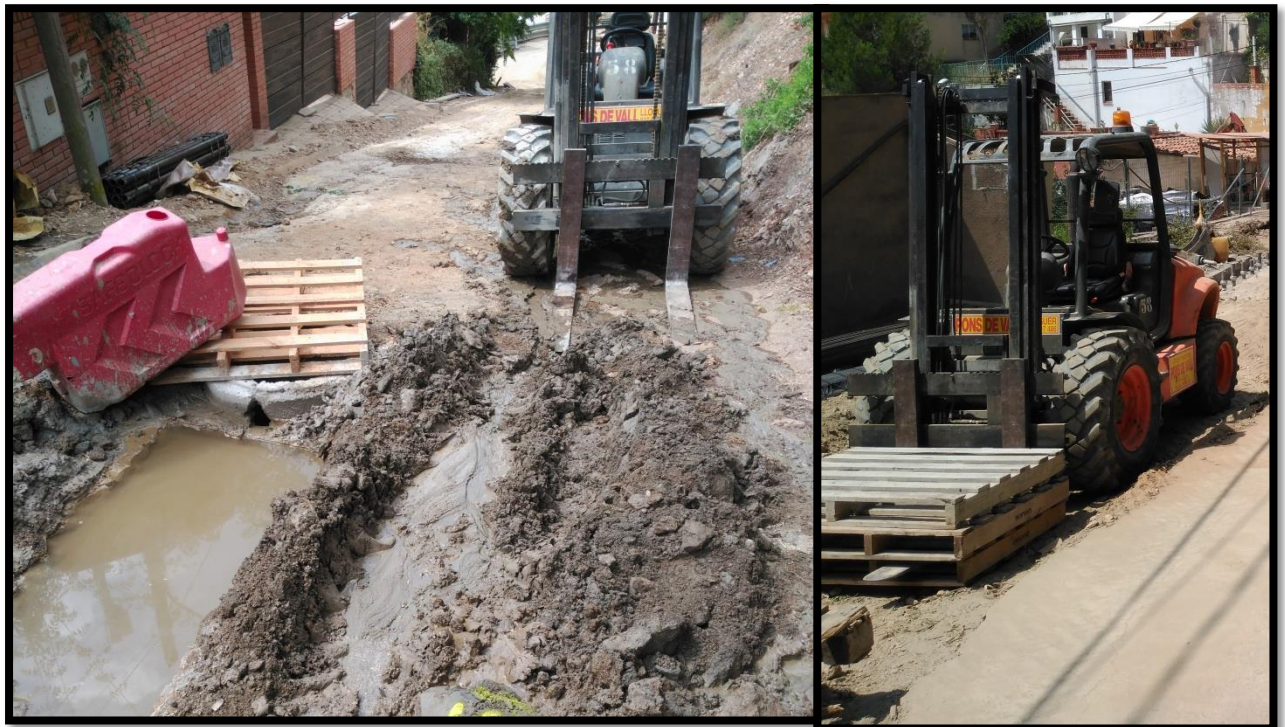
Toro desplazando materiales de la obra por la zona de actuación
