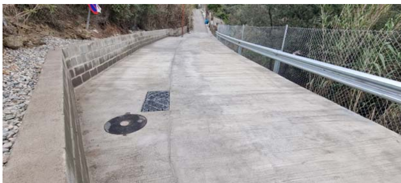
Estat final carrer estabilitzat
