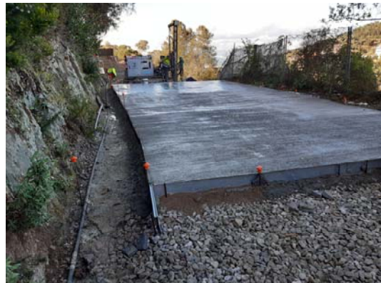
Formigonat llosa estructural
