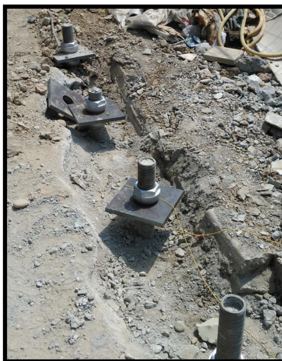
Cabeza de micropilote homologada con una placa y dos tuercas
