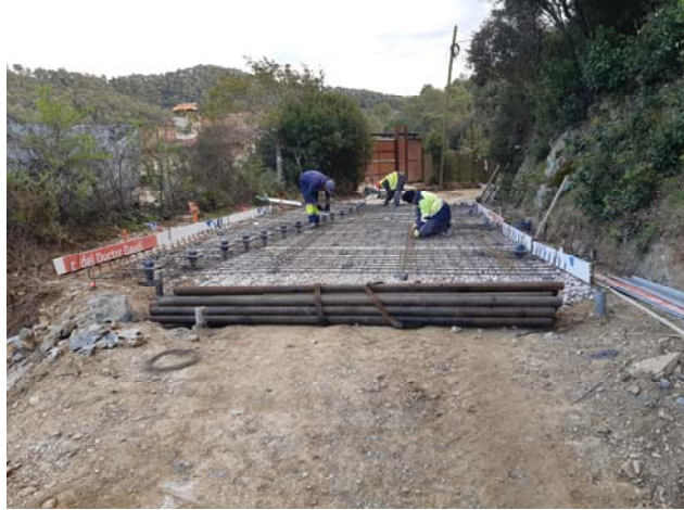
Execució micros i llosa estructural
