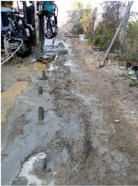
Execució micros i llosa estructural
