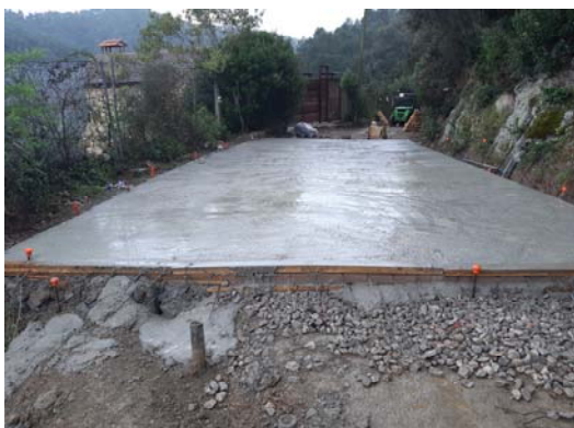
Formigonat llosa estructural
