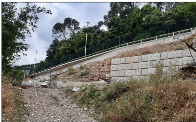
ESTAT FINAL DE L'OBRA EXECUTADA
