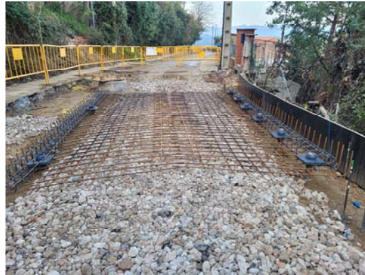
Fase de construcció
