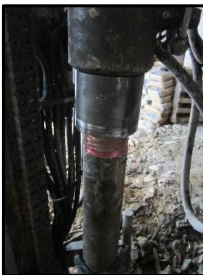
Colocación del tubo ya engrasado
