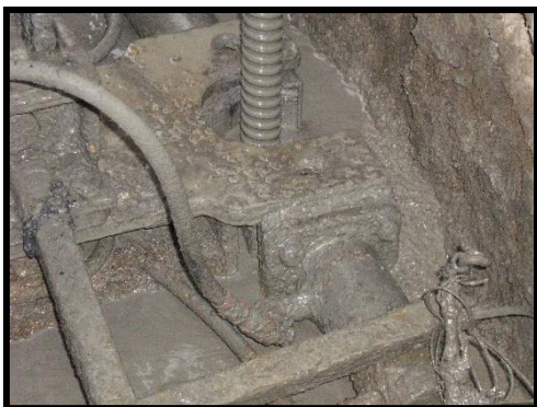
Detalle fijación del micro mediante las mordazas.
