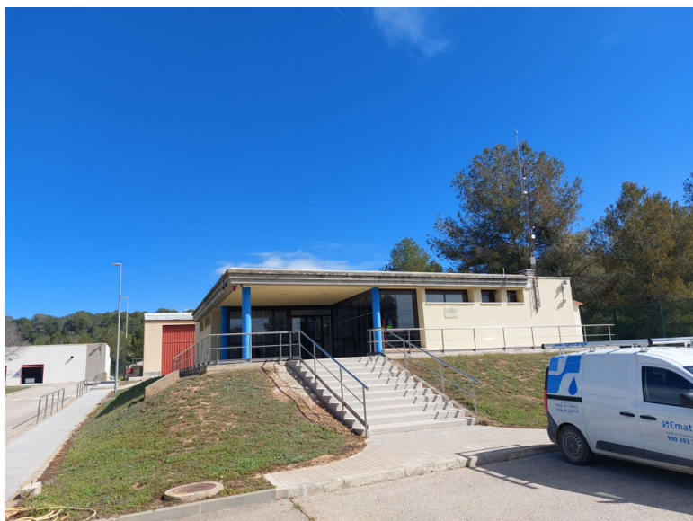
Edifici d'oficines i vestuari
