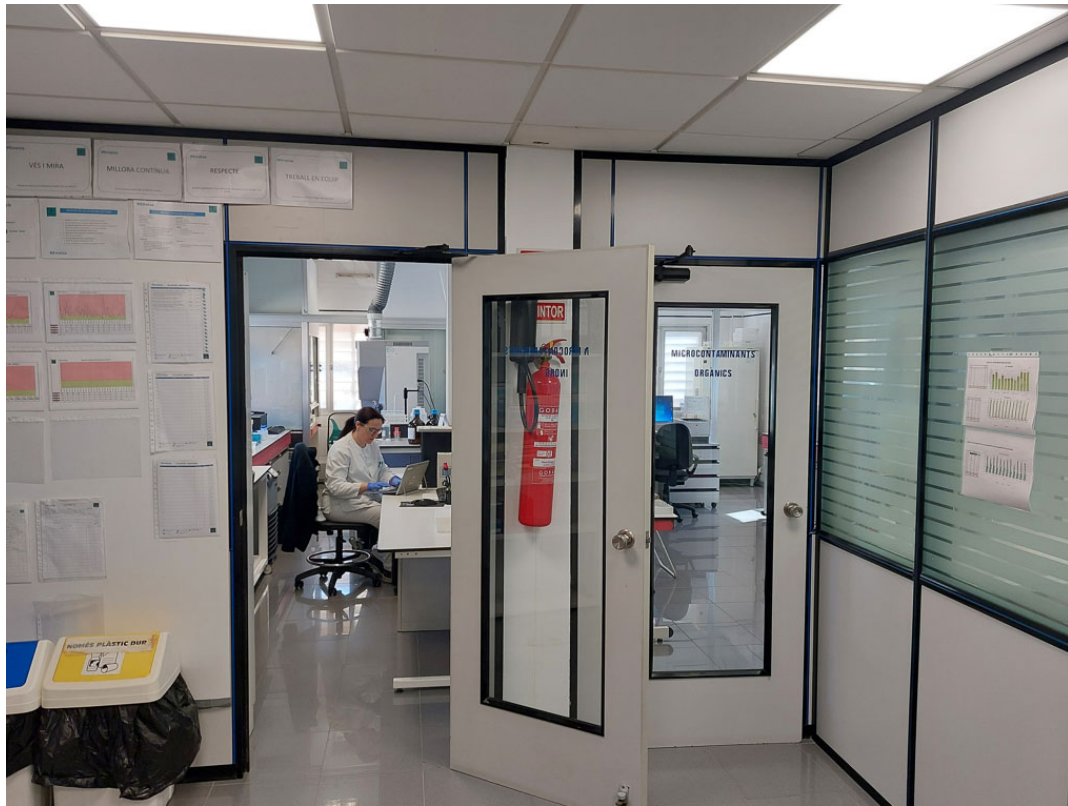
Edifici laboratoris vell
