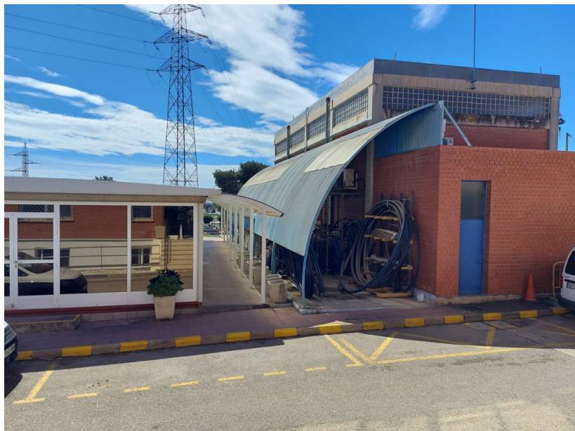
Magatzem i mòdul prefabricat
