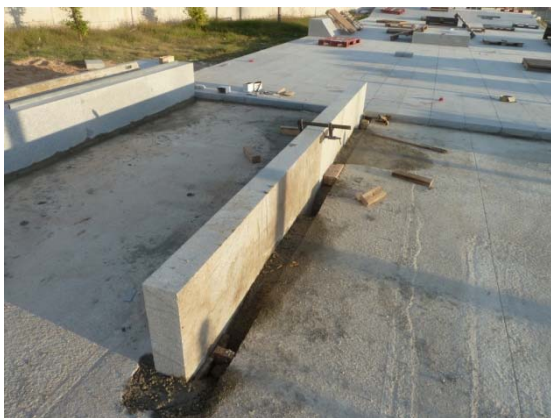
Rail de granit encastat a terra i exemple de connector amb tac químic a granit per formigonat posterior
