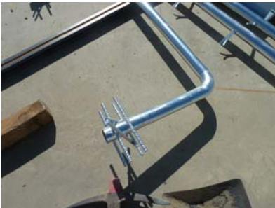
Detall Tipus d'Ancoratges de Rail
