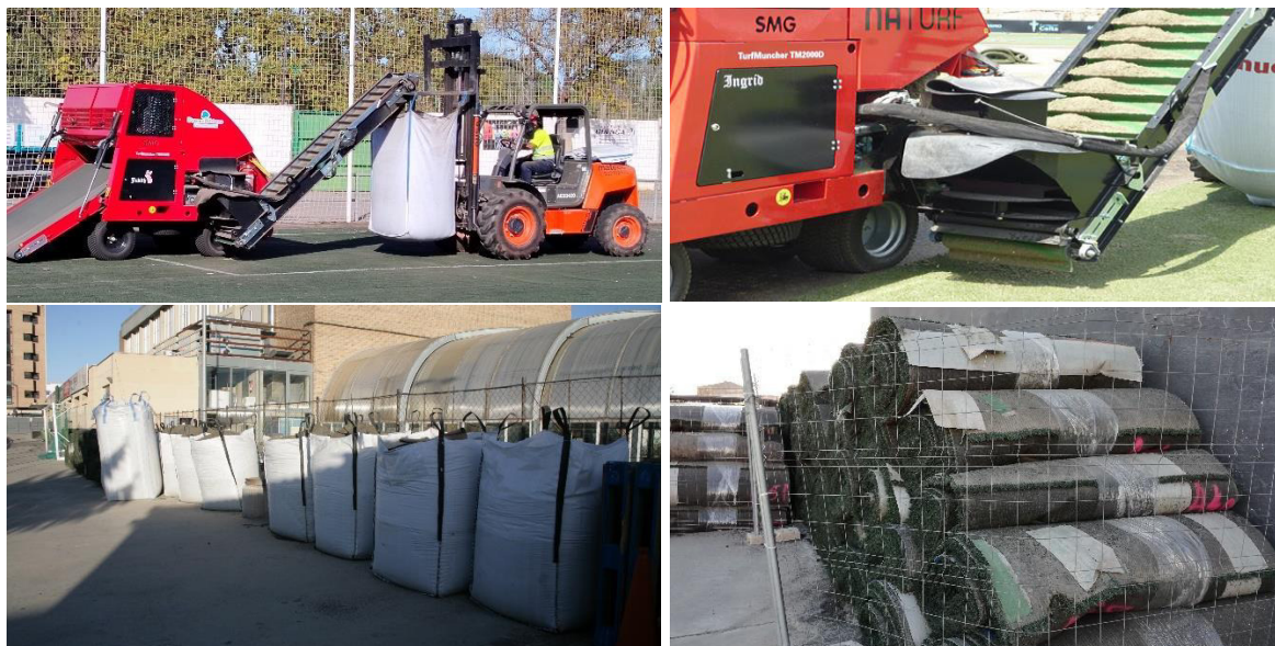
Imatges tipus del procés de desmuntatge, escombrat i aplec de la gespa a retirar.
