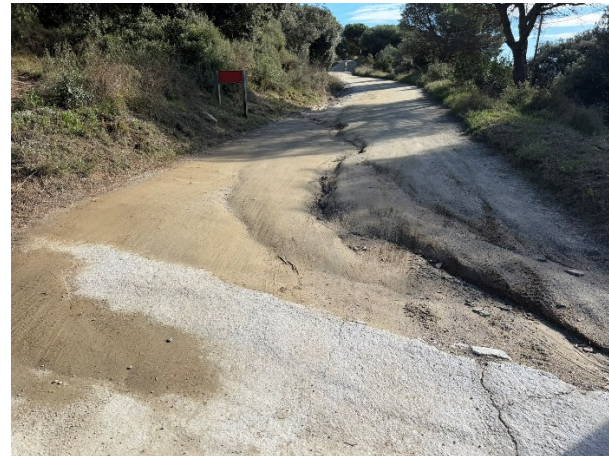
Pèrdua de material granular de l'esplanada i dels marges dels camins
