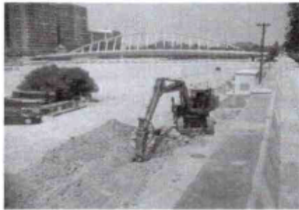
DEMOLICIÓN MECÁNICA A CIELO ABIERTO
