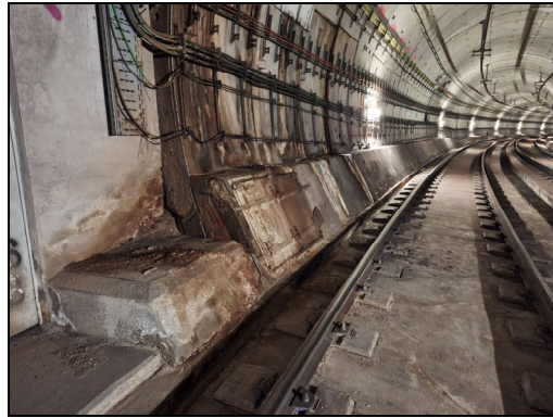
Entrada d'aigua i fang per junta sobre via 1
