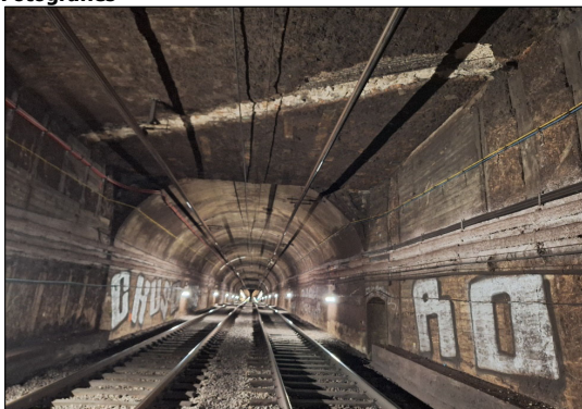
Vista de la secció tipus del túnel afectada
