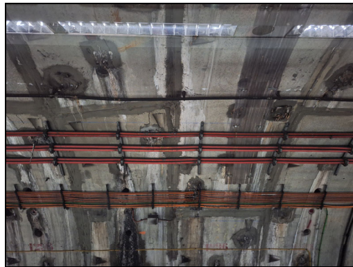
Vista del degoteig pel bolons de les dovelles
