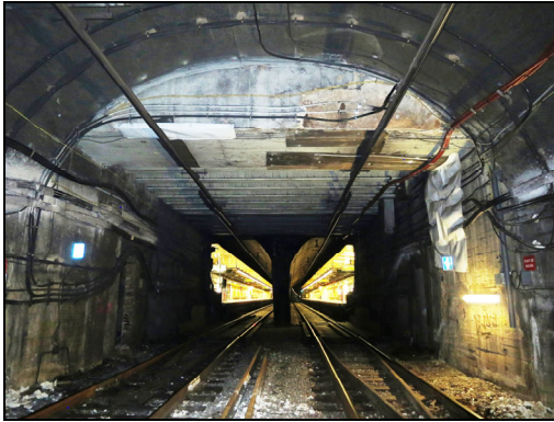
Vista de la secció de pas de serveis afectada
