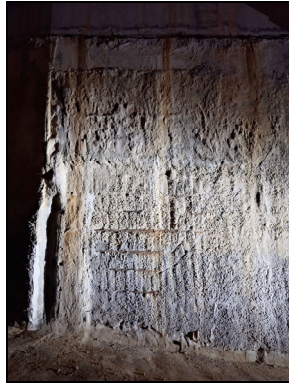
Armadures vistes pantalla 31
