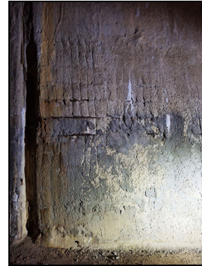
Armadures vistes pantalla 32
