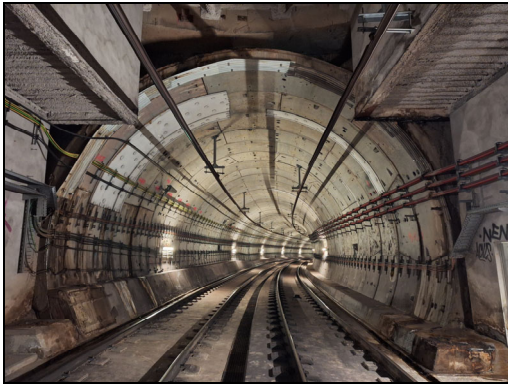
Vista de la junta entre Pou 6D i túnel rodó
