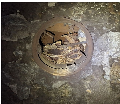
Detall forat volta al PK 117+680
