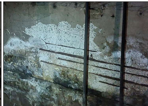
Detall del desprendiment del formigó de recobriment
