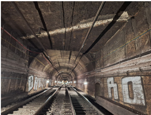
Vista de la secció de pas de serveis afectada
