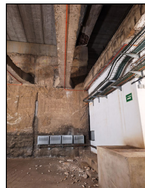
Vista lateral de la biga
