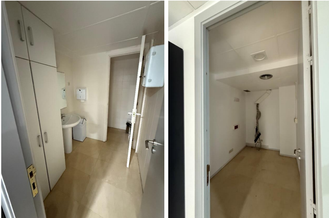
Bany i cambra del rack al local 1B
