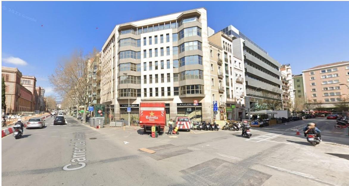
Façana de l'edifici Rostower al xamfrà Rosselló-Urgell. A la dreta l'edifici del CEK i al fons l'entrada de Villaroel de l'Hospital Clínic.
