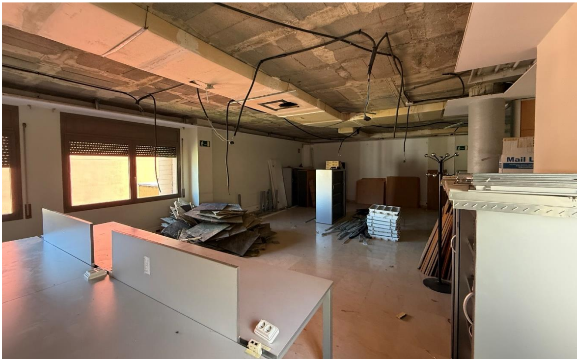
Planta sisena A. Espai que dona al pati interior. El local és buit de conductes, instal·lacions, enderrocs i mobiliari
