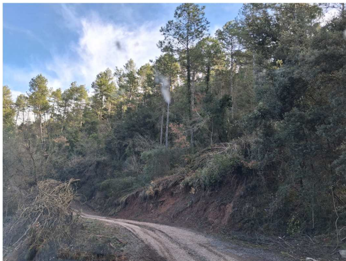
Pista principal d'accés (engravada) de la finca la Garriga. Al final dels treballs ha de quedar en bon estat.
