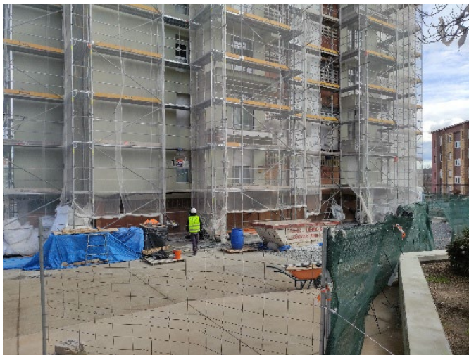
Obres en curs en l'àmbit d'actuació referides en el planning
