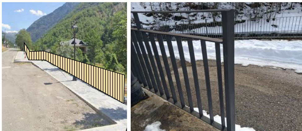
Imatge 9. Barana per a facilitació de la mobilitat reduïda i protecció de caigudes.
