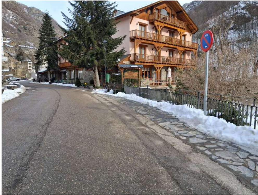
Imatge 4. Vorerres enrasades amb la calçada a tot el llarg de la travessera de Tavascan.
