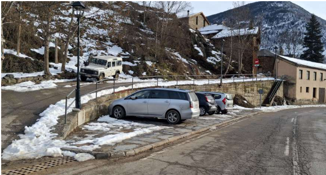
Imatge 3. Espai d'aparcament a Lladorre. La vorada no és remuntable i és difícil d'accedir a l'espai d'aparcament.
