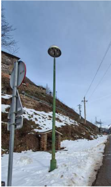
Imatge 15. Fanal de vapor de sodi a substituir. Espai on es reforçarà l'enllumenat amb un fanal solar, correspon a l'estació de càrrega de vehicles elèctrics.
