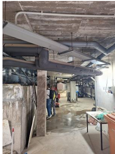
Fotografies 5 i 6.- Conducció evacuació fums de les calderes de ACS i conductes de distribució d'aigua calenta a les piscines, situades la part inferior de les mateixes a 1'85 i a 2'1 metres, respectivament, a la zona de pas cap al emplaçament de la nova refredadora.
