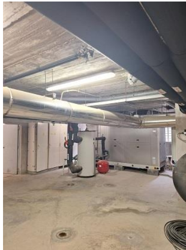
Fotografies 5 i 6.- Conducció evacuació fums de les calderes de ACS i conductes de distribució d'aigua calenta a les piscines, situades la part inferior de les mateixes a 1'85 i a 2'1 metres, respectivament, a la zona de pas cap al emplaçament de la nova refredadora.
