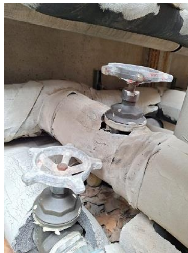
Fotografies 3 i 4.- Conjunt de vàlvules del sistema de refrigeració i conjunt de vàlvules del sistema de calefacció, situades a la pròpia coberta, annexes a la refredadora, a substituir.
