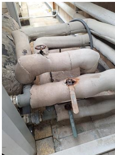
Fotografies 3 i 4.- Conjunt de vàlvules del sistema de refrigeració i conjunt de vàlvules del sistema de calefacció, situades a la pròpia coberta, annexes a la refredadora, a substituir.
