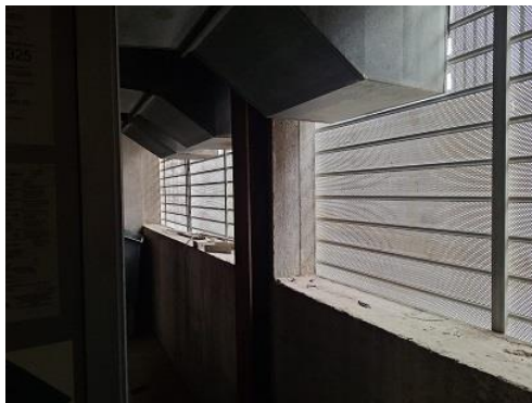
Fotografies 2 i 3.- Reixes en contacte permanent al exterior, annexes a la refredadora i conductes de xapa per conducció del aire de refrigeració de la refredadora al exterior.
