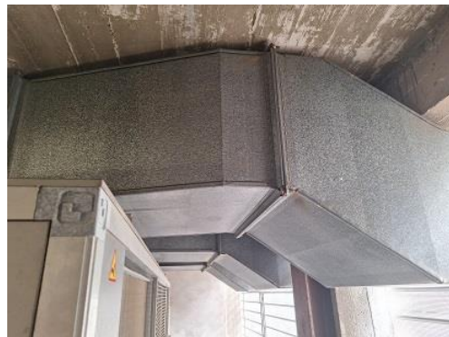
Fotografies 2 i 3.- Reixes en contacte permanent al exterior, annexes a la refredadora i conductes de xapa per conducció del aire de refrigeració de la refredadora al exterior.
