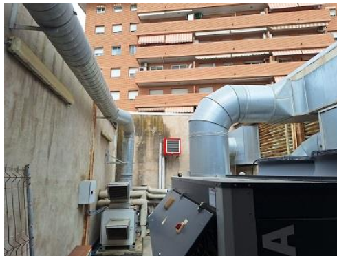
Fotografia 2.- Accés a la coberta on es troba la refredadora substituir, accessible del exterior mitjançant una grua autopropulsada.
