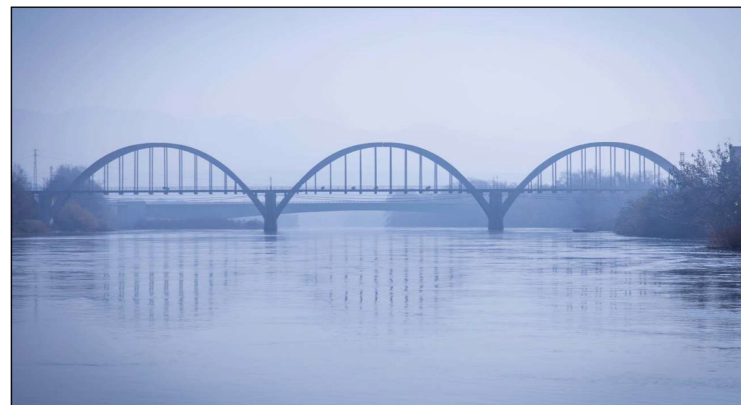
Fig. Núm 5. Nou pont a Móra d'Ebre, finalitzat al 1943
