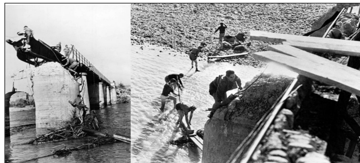
Fig. Núm 4. Restes del Pont de Ferro, i de la retirada de les seves restes
