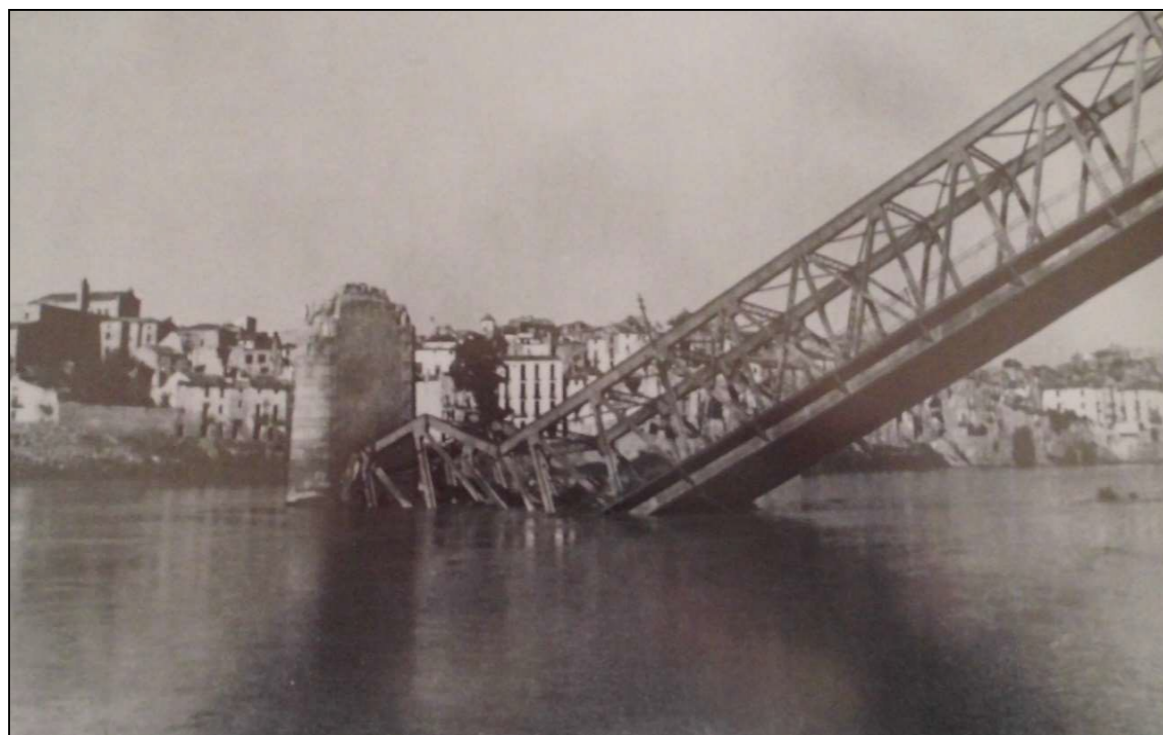
Fig. Núm 3. Pont de Ferro existent, un cop volat el 3 d'abril de 1938
