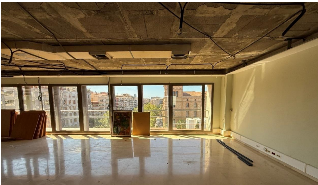
Planta sisena C. Espai que dona al carrer Urgell. El local és buit de conductes i instal·lacions
