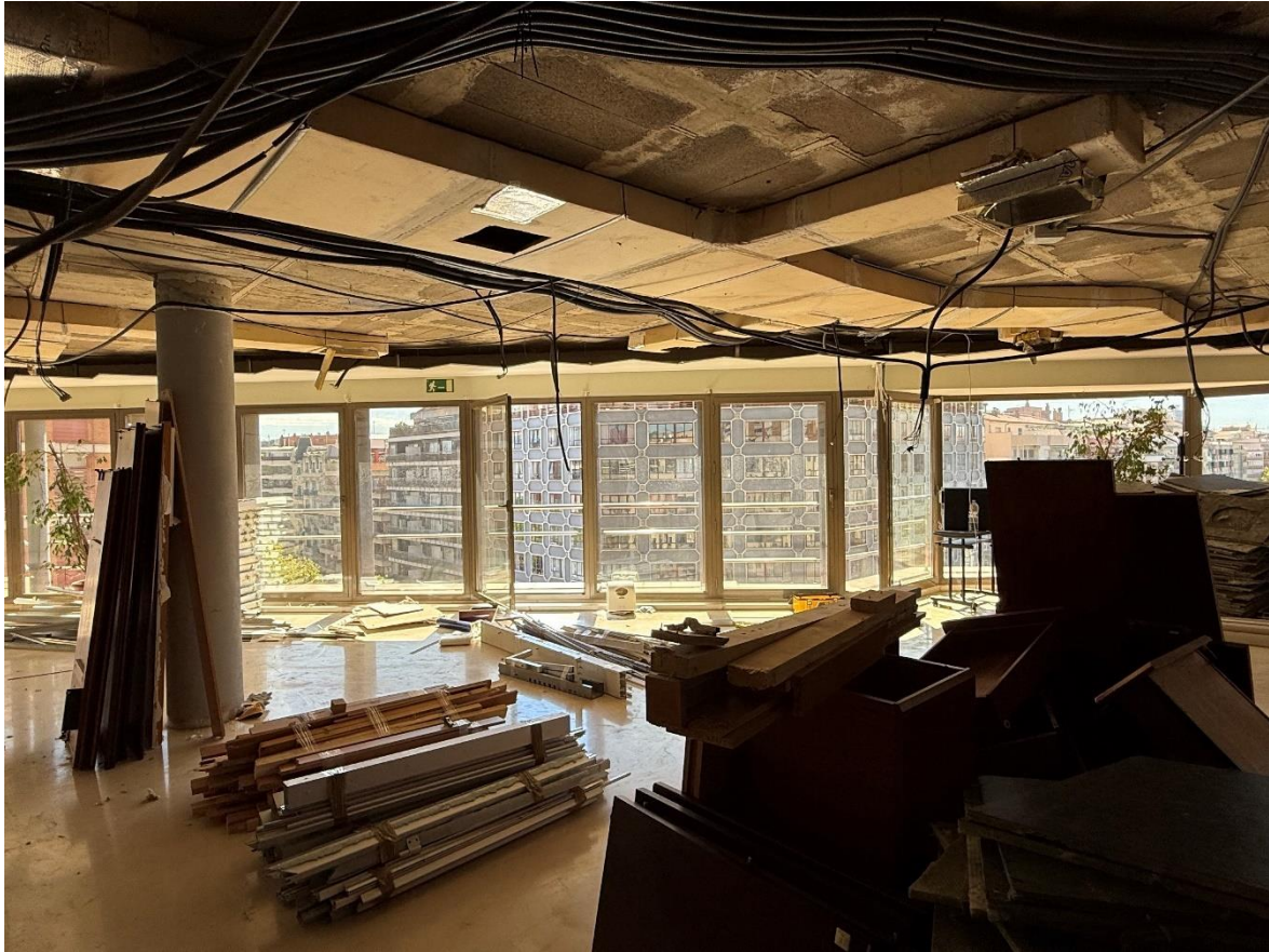
Planta sisena B. Espai que dona al xamfrà. El local és buit de conductes i instal·lacions i enderrocs
