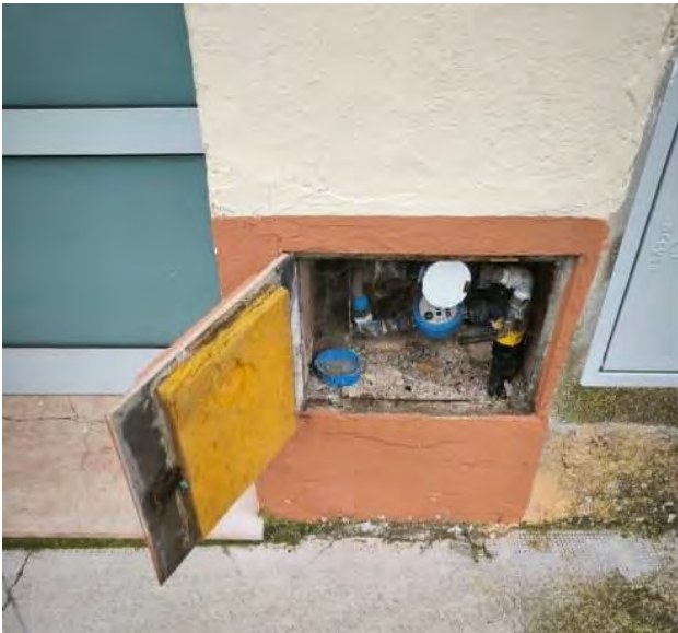
Portella existent amb dos comptadors a l'interior
