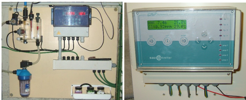
Lectures dels valors de monitoratge del ph i clor lliure dels automats
