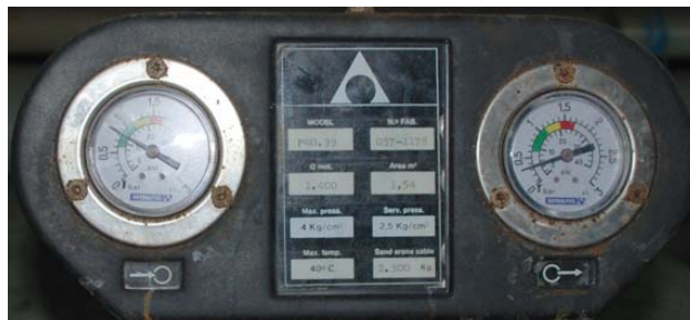
Manòmetres de control de la saturació d'un filtre
