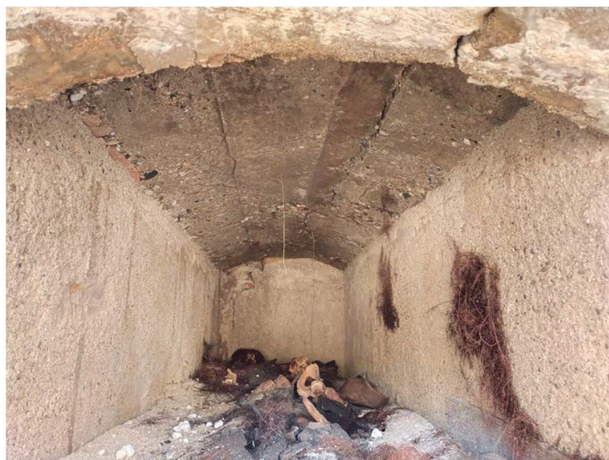
Nínxol 3732 Bloc 160 – Esquerra a la façana i a tota la longitud de la volta
