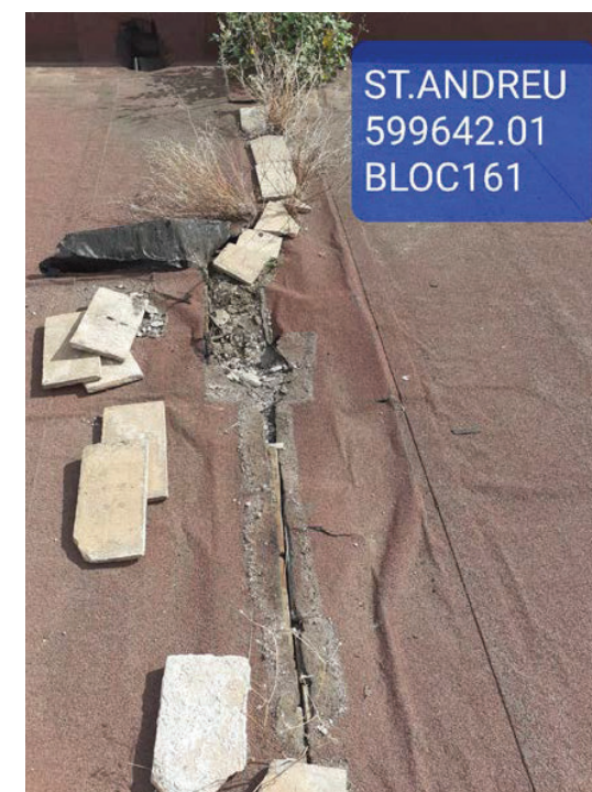
Estat de la coberta gener 2023
