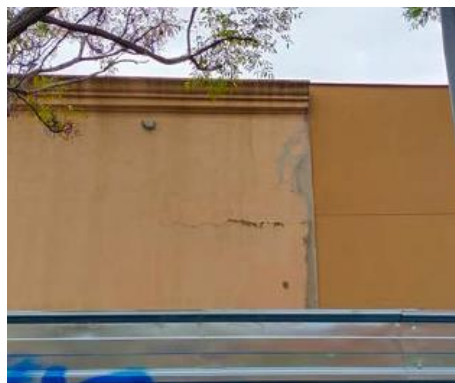
Clinòmetre CL037 al bloc 37
