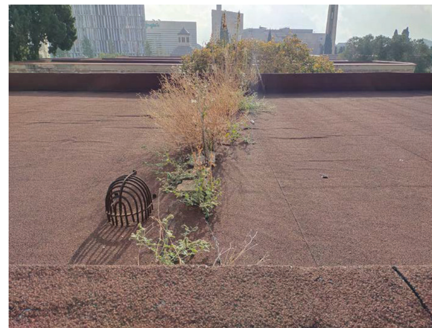
Estat de la coberta del conjunt de blocs
