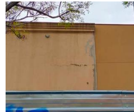
Clinòmetre CL037 al bloc 37
