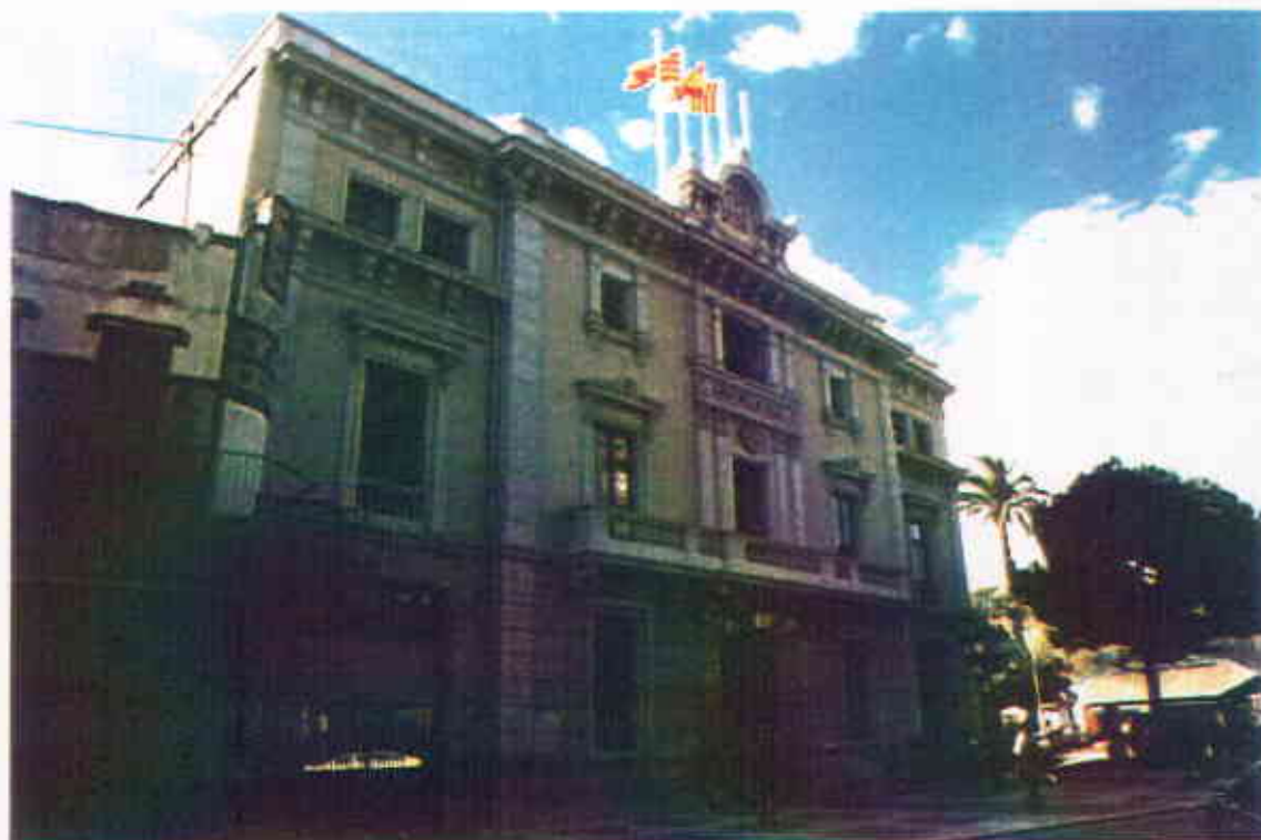
Vista general de la façana principal (Abril 1996).
