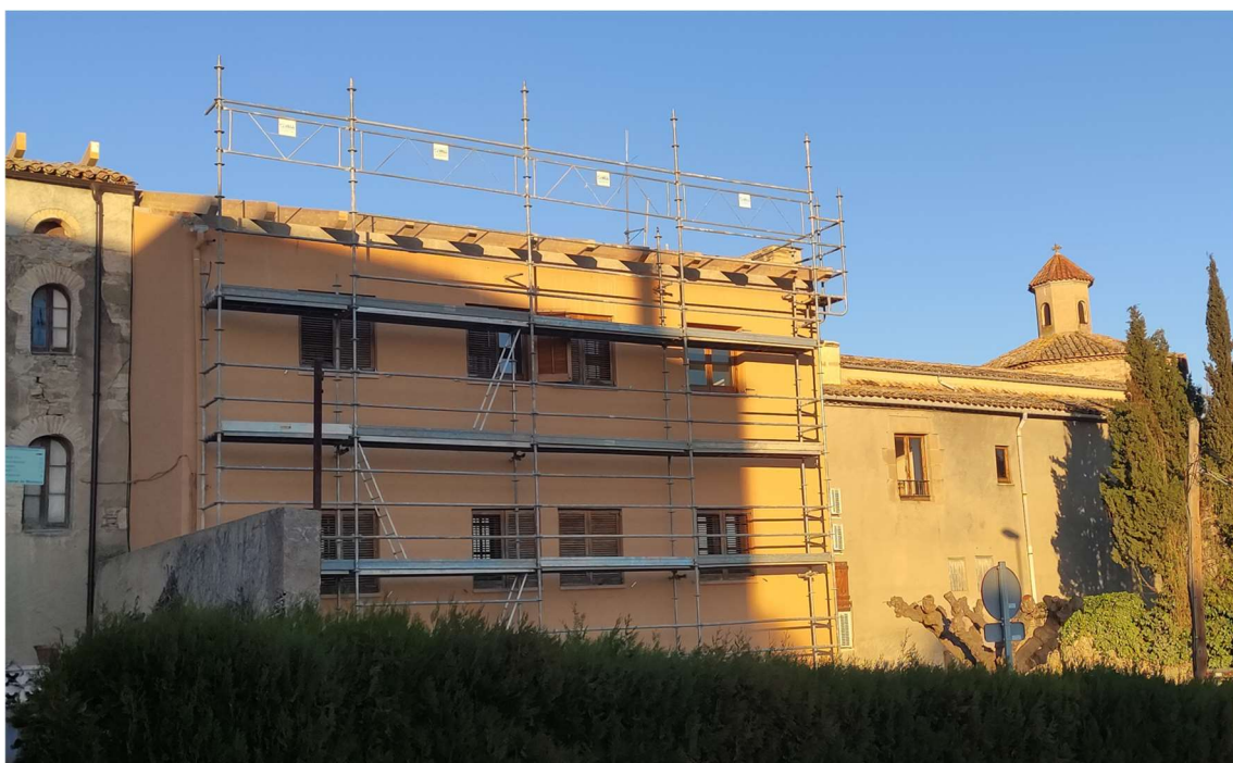
Fotografia façana posterior
