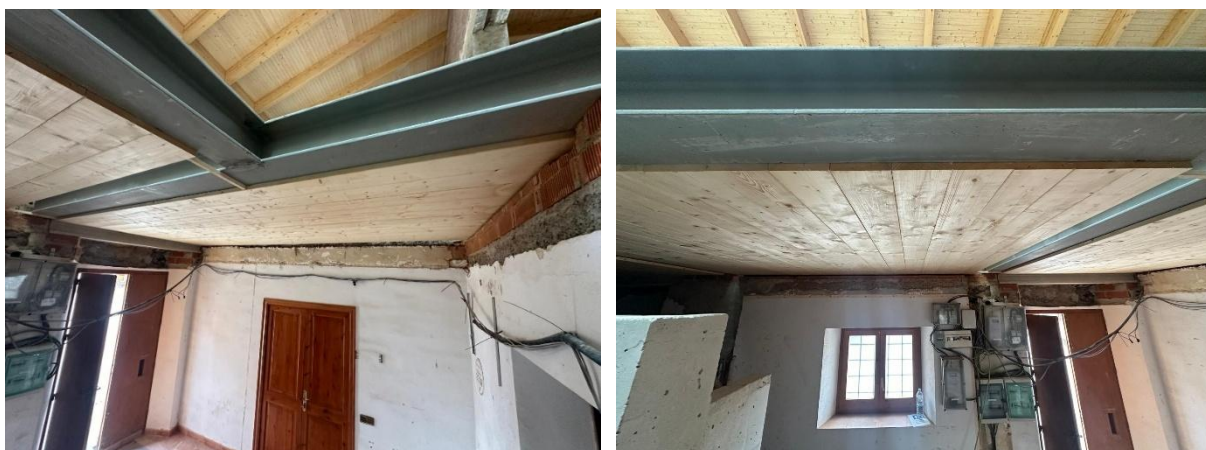
Imatges de la crugia històrica, nivell \pm 0,00\text{m} . Espai de recepció amb sostre de bigues girades de fusta ja muntat.
