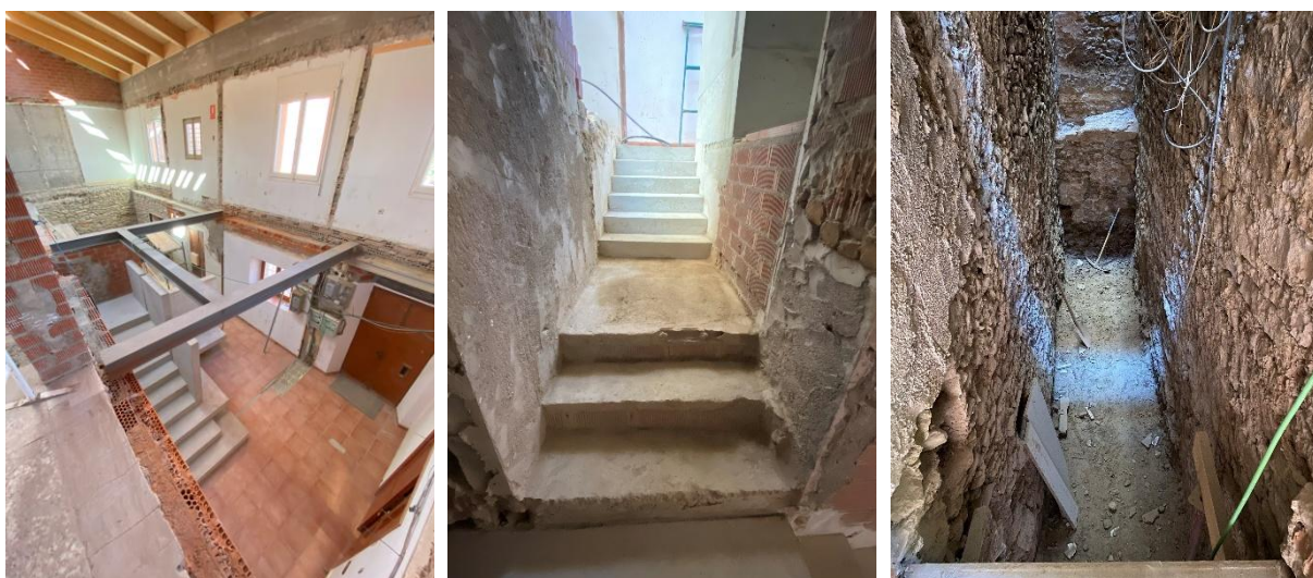
Imatges de la crugia històrica, nivell \pm 0,00\text{m} . D'esquerra a dreta, imatge aèria amb sostre pendent de muntar, escala de PS a PB, visual pati des de l'escala.
