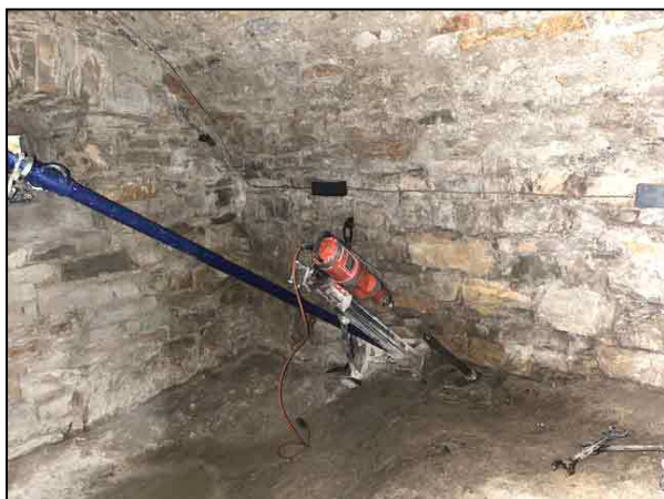
Foto 1. Treballs de realització del sondeig S1
