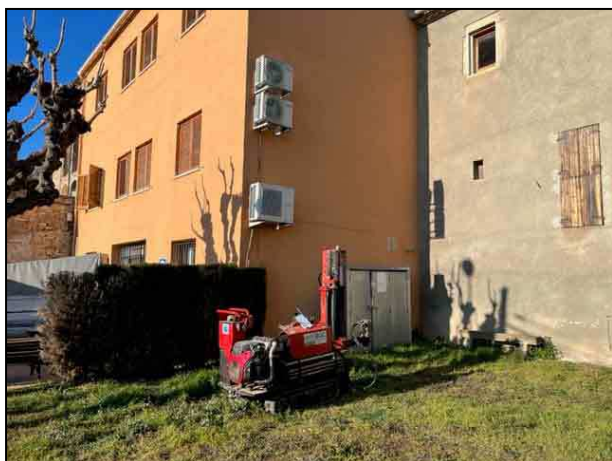
Foto 3. Treballs de realització del sondeig P1.
