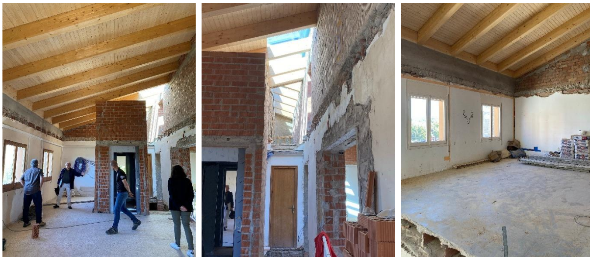
Imatges de la crugia de l'ampliació, nivell +3,40m. D'esquerra a dreta, espai diàfan amb ascensor, relació visual amb el pati de llum, espai sobre antic despatx alcaldia.
