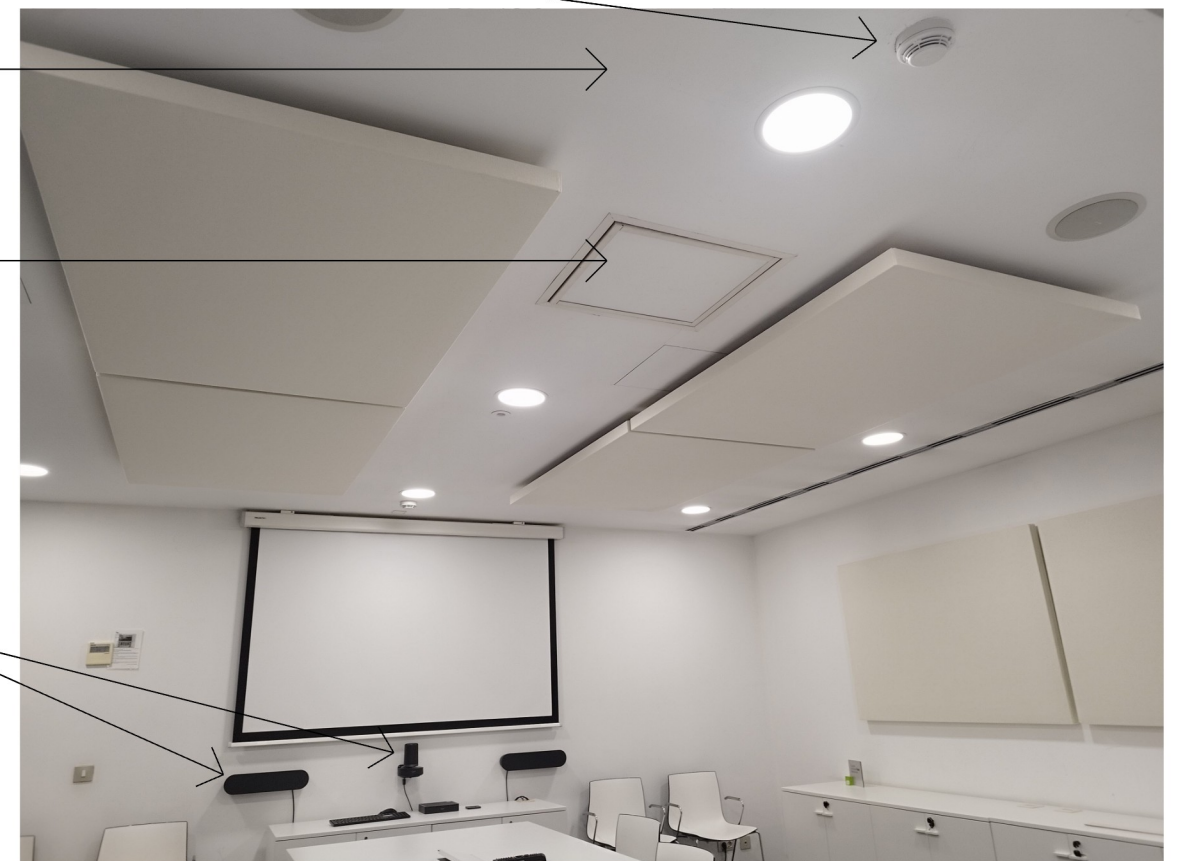
Sostre de plaques de guix laminat
