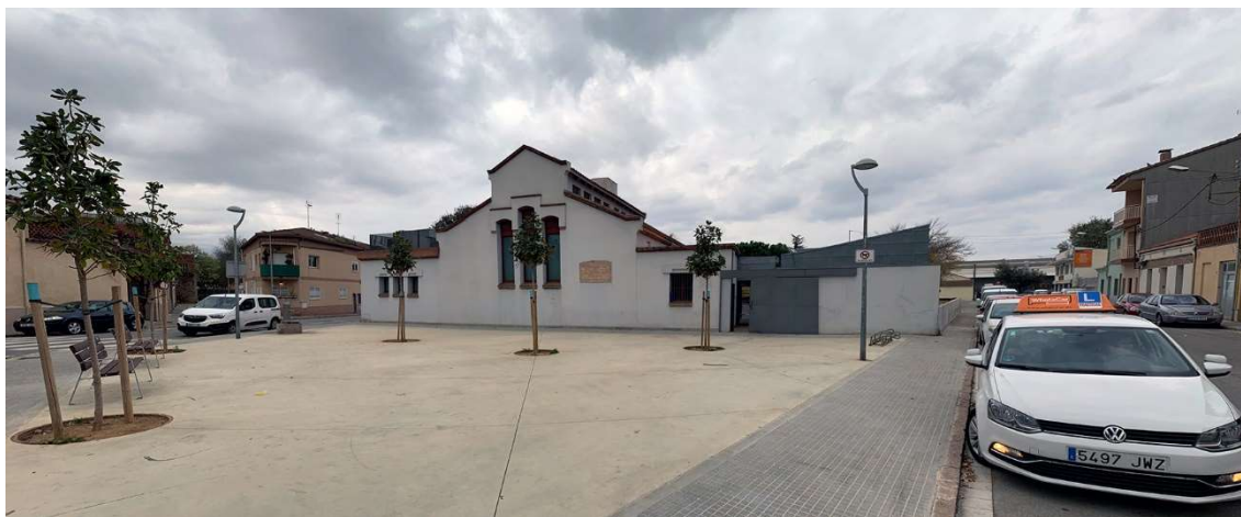
Figura 1./ Estat actual de la Façana Est – Accés principal.
