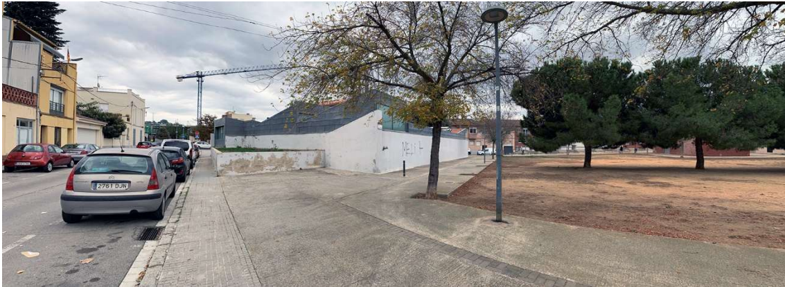
Figura 2./ Estat actual de la Façana Oest.
