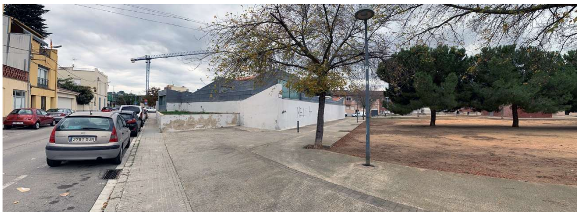
Imatge2./ Façana oest.
