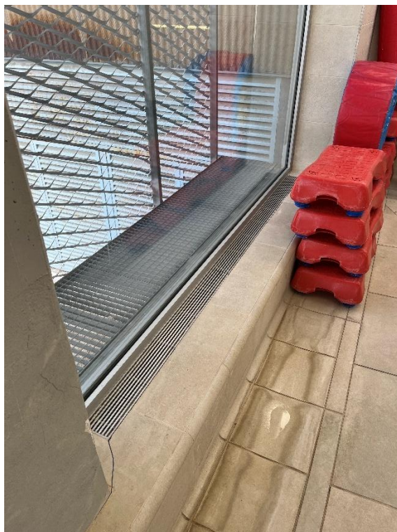
Reixetes a terra de retorn d'aire al perímetre de la piscina
