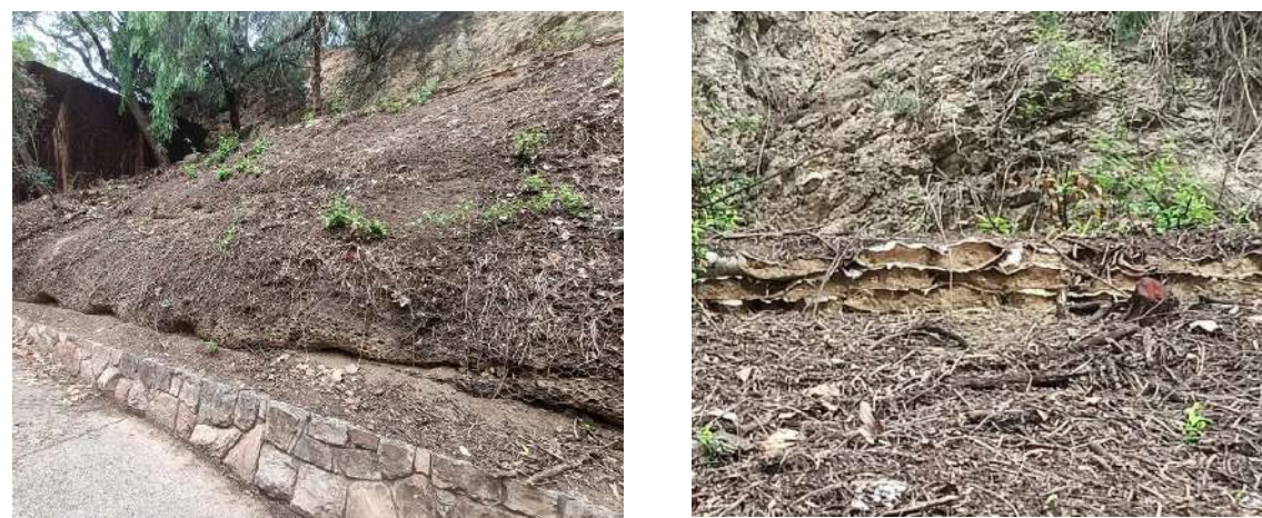
Fig.8: Estructures de terra armada i detall dels sacs de plàstic amb terra esquinsats al cap de talús
