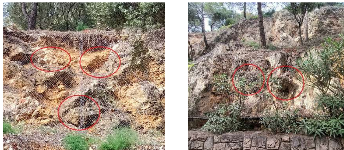
Fig.7: Embossaments de pedres caigudes en les malles d'acer.
