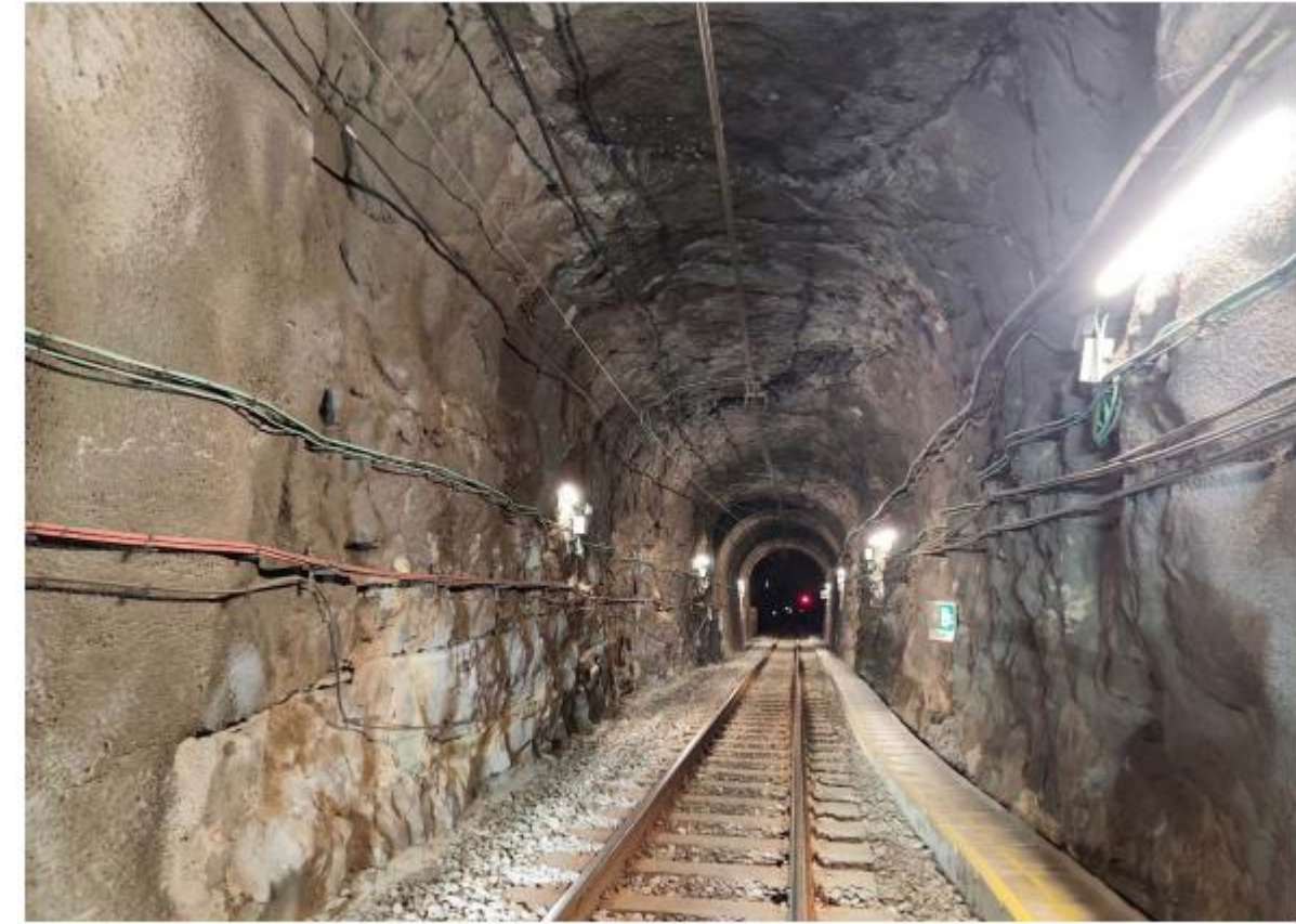
Fotografia PA _010: Vista general de secció de túnel . PK 58+729
