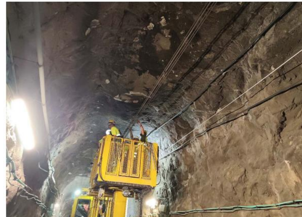
Fotografia PA_014: Pèrdua de la capa de segellat de la gunita . PK 58+758
