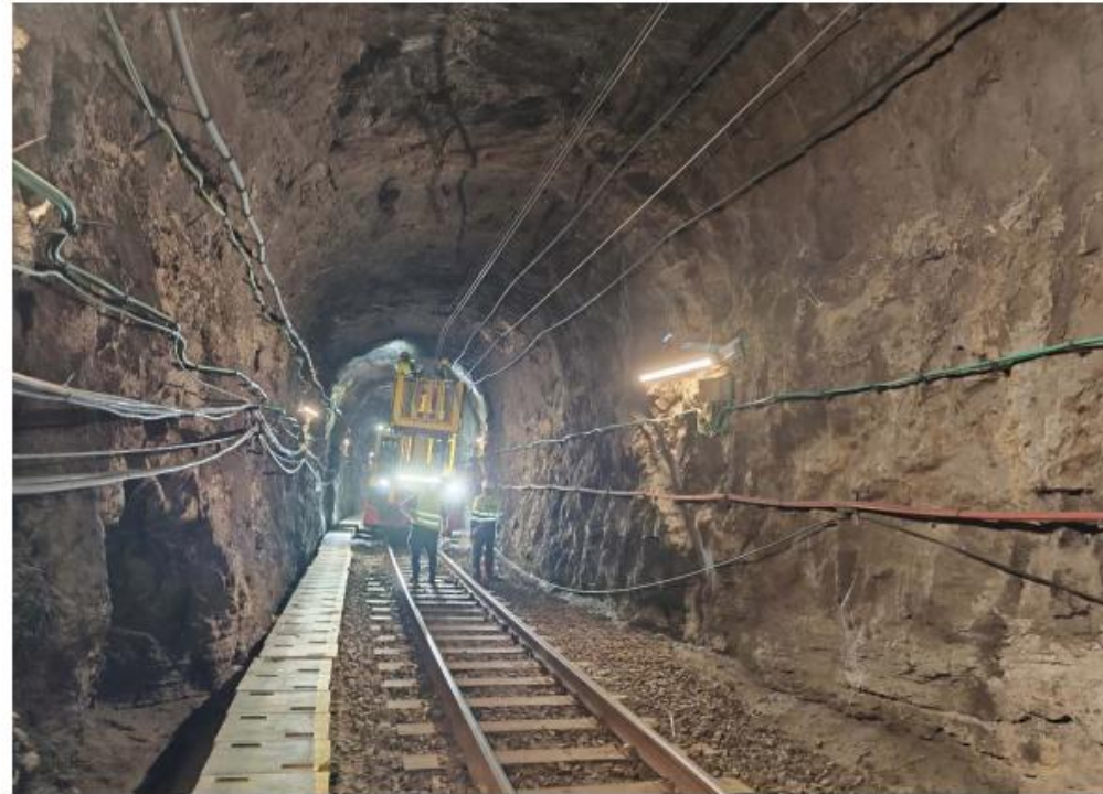
Fotografia PA_026: Vista general de secció de túnel . PK 58+858
