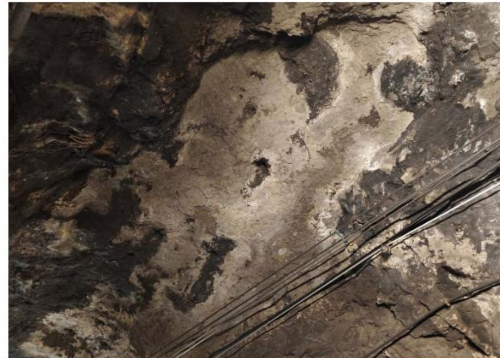
Fotografia PA_028: Detall goteigs i saneig. PK 58+885
