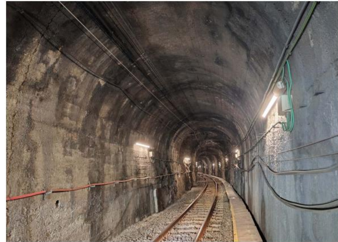
Fotografia PA_032: Vista general de Secció de túnel direcció Martorell . PK 58+926
