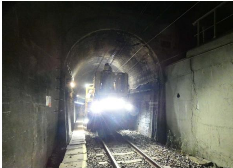
Fotografia PA_001: Vista general de l'embrocament costat Martorell . PK 58+683
