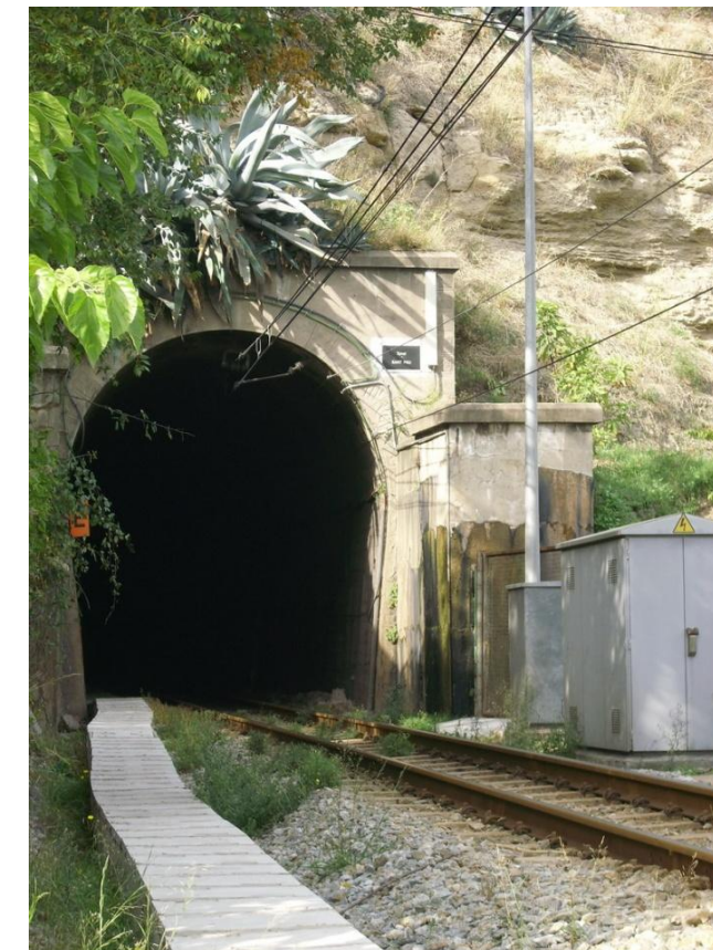
Fotografia 1. Boca Sud del túnel de Sant Pau.
