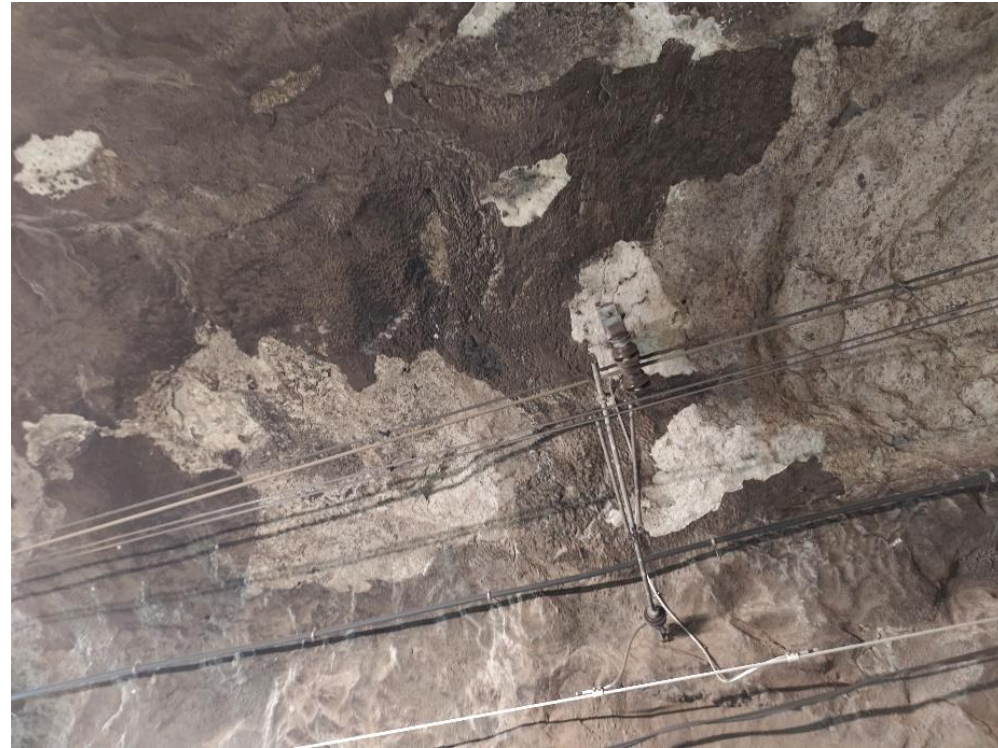
Figura 9. Saneig de la zona sense revestiment Pk 58+758 – 58+776.
