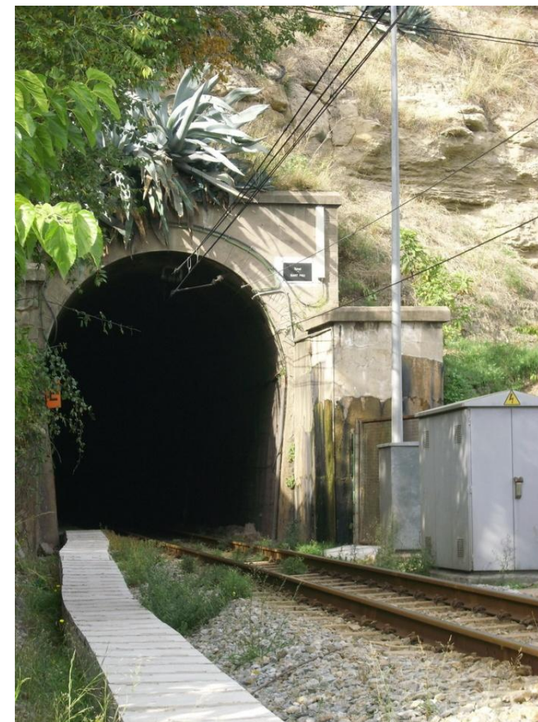
Fotografia 1 : boca Sud del túnel de Sant Pau.
