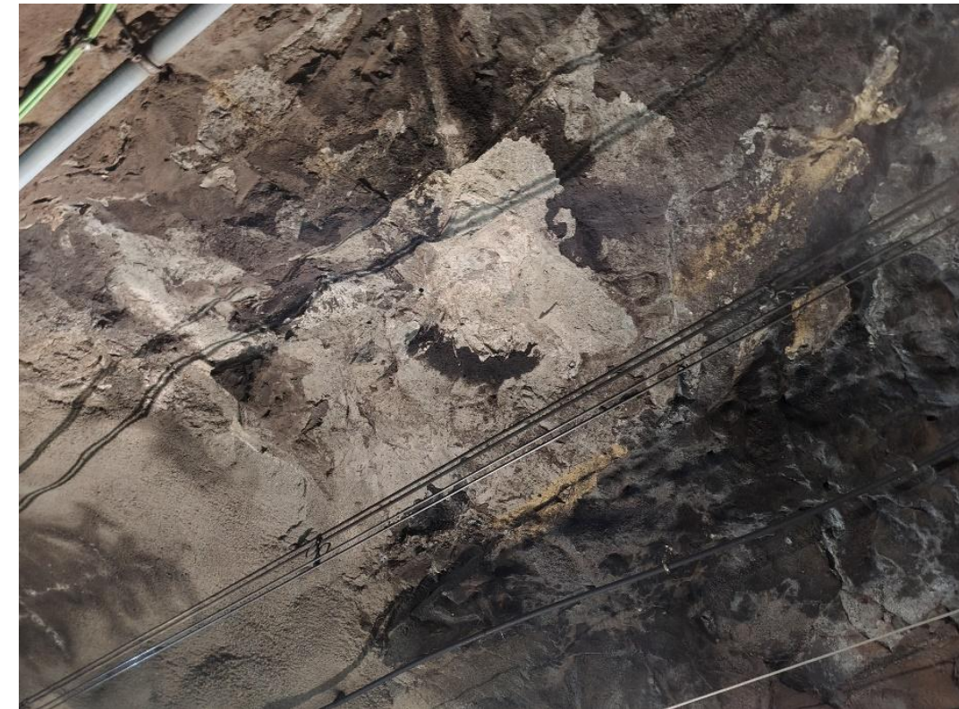
Figura 7. Detall del saneig Pk 58+750.
