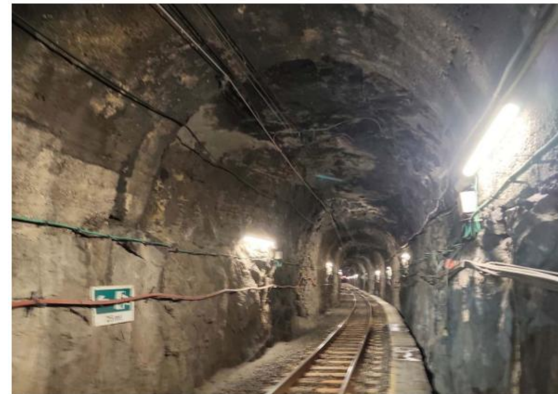
Fotografia PA_033: Vista general de Secció de túnel direcció Martorell . PK 58+920
