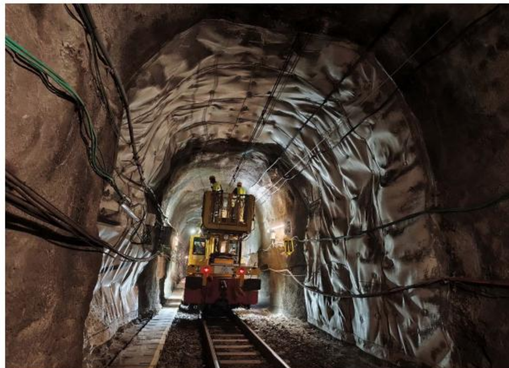
Fotografia PA_020: Vista general de secció de túnel . PK 58+818
