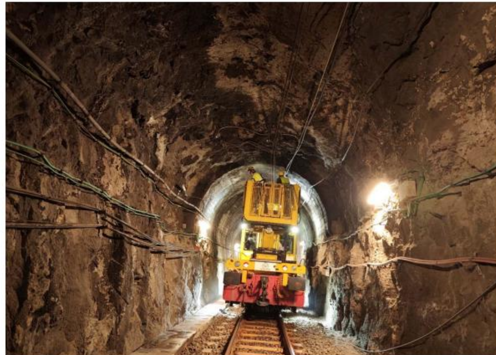
Fotografia PA_027: Vista general de secció de túnel . PK 58+885
