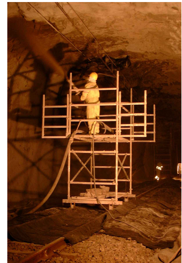
Les bastides habilitades per a circular sobre carrils han de disposar d'un sistema de frenada i complir totes les prescripcions relatives a bastides. Ha de garantir-se la seva estabilitat i equilibri per a tota activitat que pugui realitzar-se des d'elles, i especialment les activitats que provoquen reaccions importants, com són la perforació amb martell de columna, la col·locació d'armadura i la projecció de formigó.
