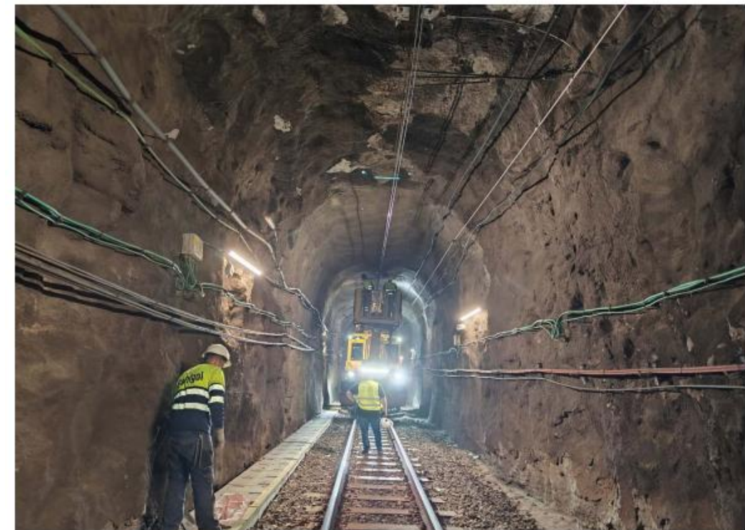
Fotografia PA_018: Vista general de secció de túnel . PK 58+783
