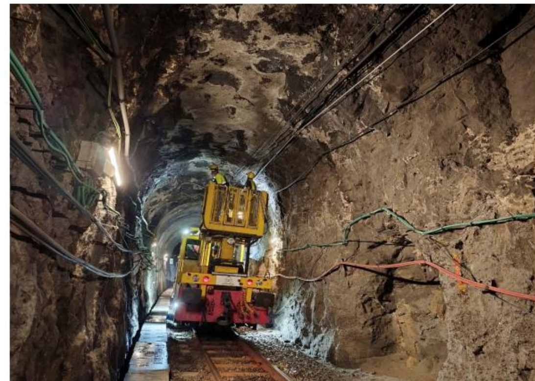
Fotografia PA_029: vista general goteig. PK 58+885
