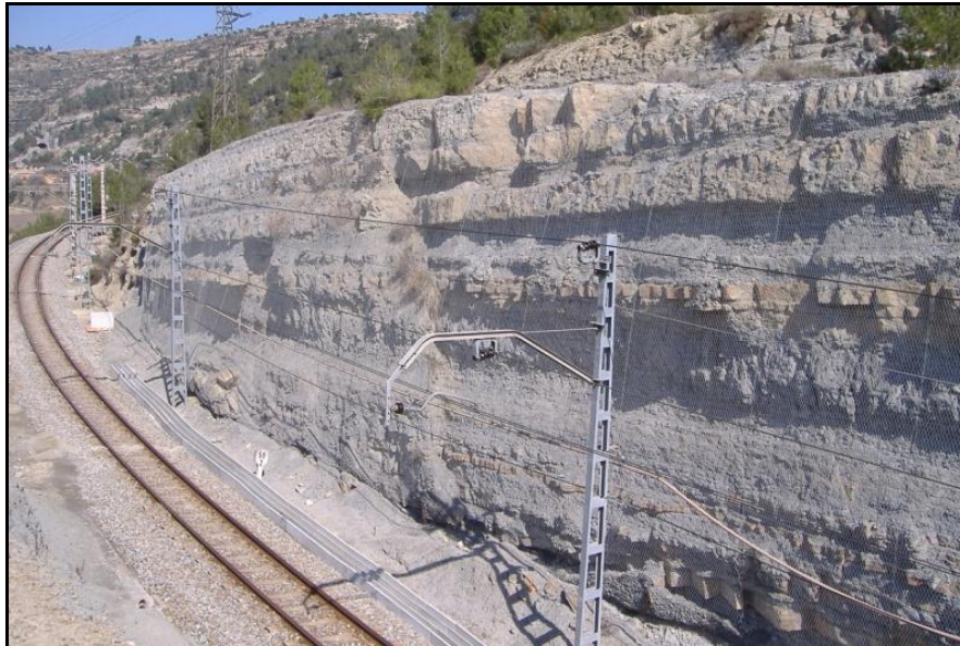
Fotografia 2. Vergència dels estrats a la sortida de la boca Nord.
