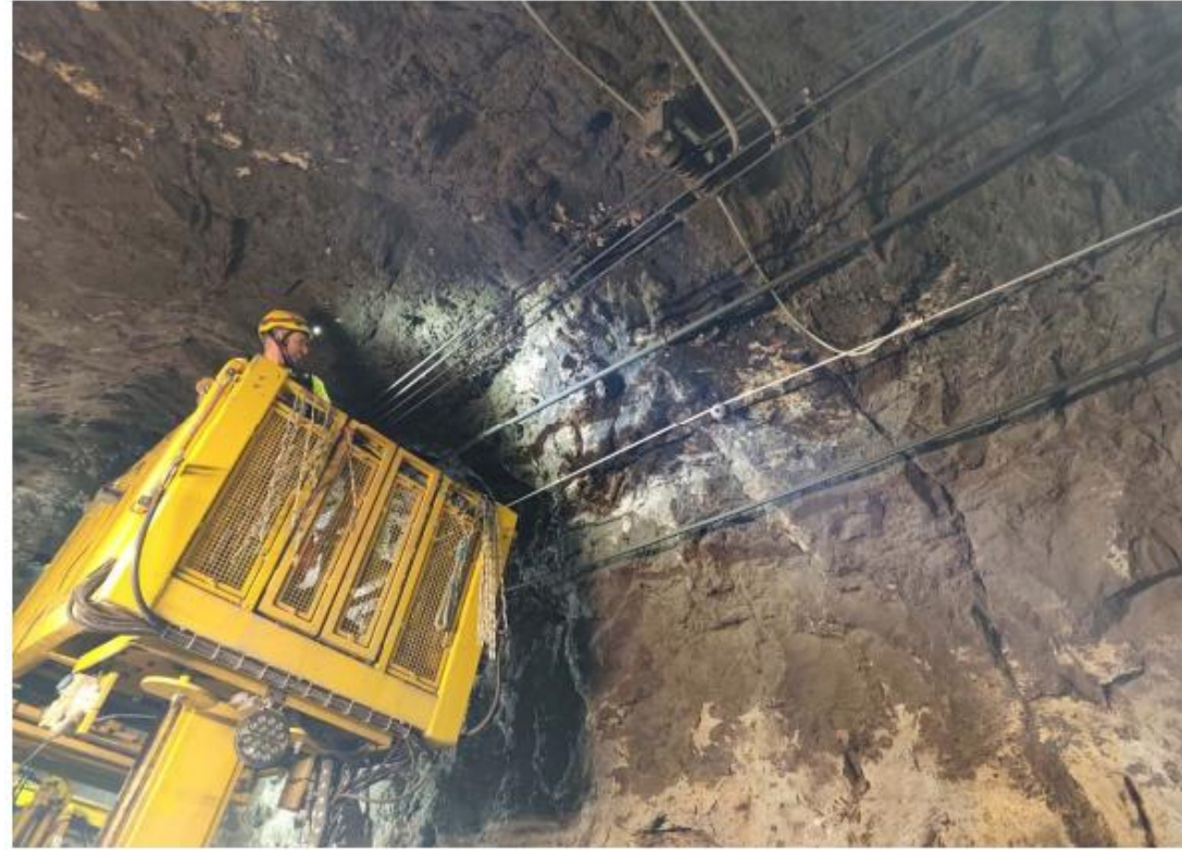
Fotografia PA_023: Detall fragment i saneig. PK 58+868
