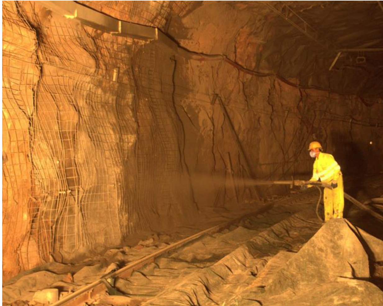
Fotografia 5. Exemple de protecció de la via.
