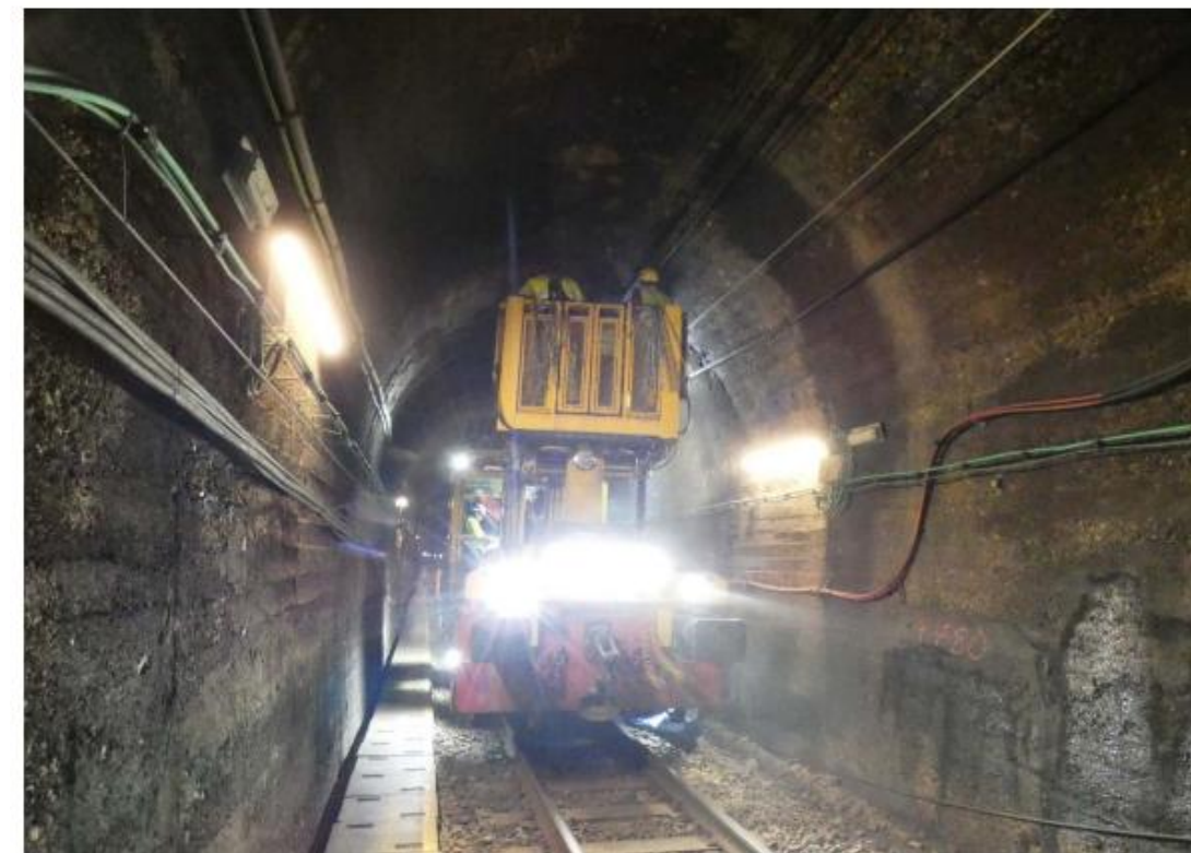
Fotografia PA_004: Vista general de secció de túnel . PK 58+688
