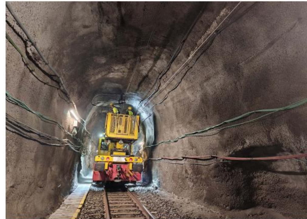
Fotografia PA_021: Vista general de secció de túnel . PK 58+833
