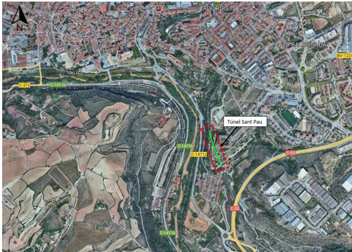
Figura 1-1. Localització del Túnel de Sant Pau.
