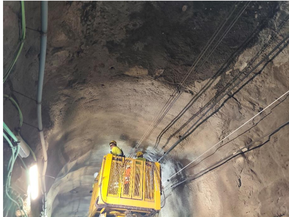
Figura 5. Vista general entre la zona sense sosteniment amb la zona de gunita Pk 58+726.
