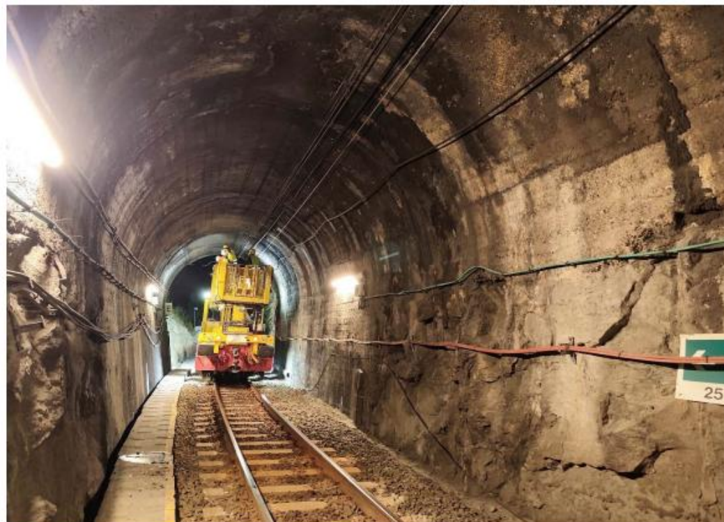
Fotografia PA_031: Vista general de secció de túnel . PK 58+918
