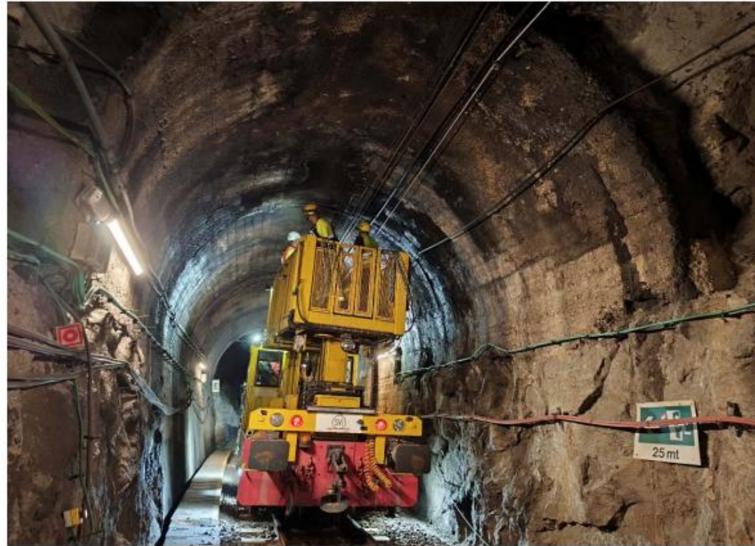
Fotografia PA_030: Vista general de secció de túnel . PK 58+898
