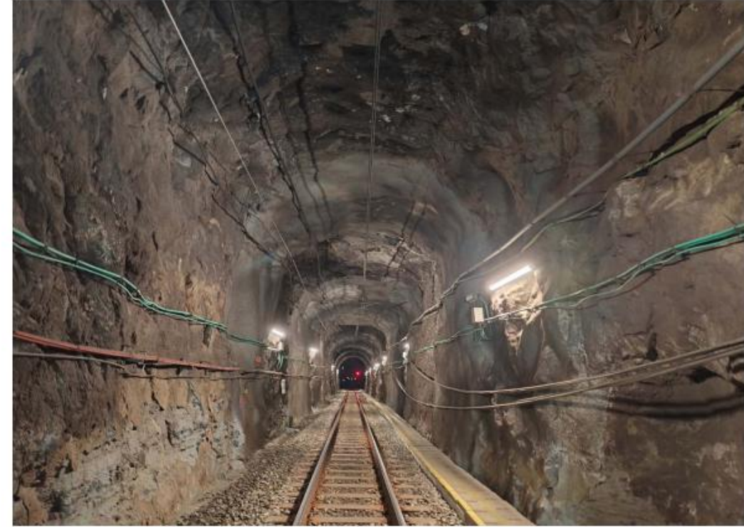
Fotografia PA_017: Vista general de secció de túnel . PK 58+773
