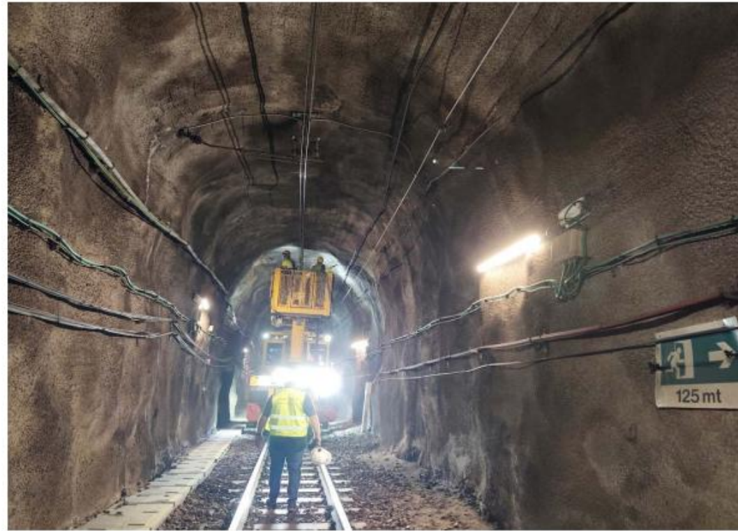
Fotografia PA_019: Vista general de secció de túnel . PK 58+808
