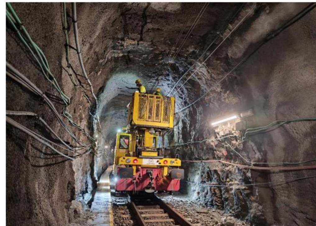
Fotografia PA_022: Vista general de secció de túnel . PK 58+843
