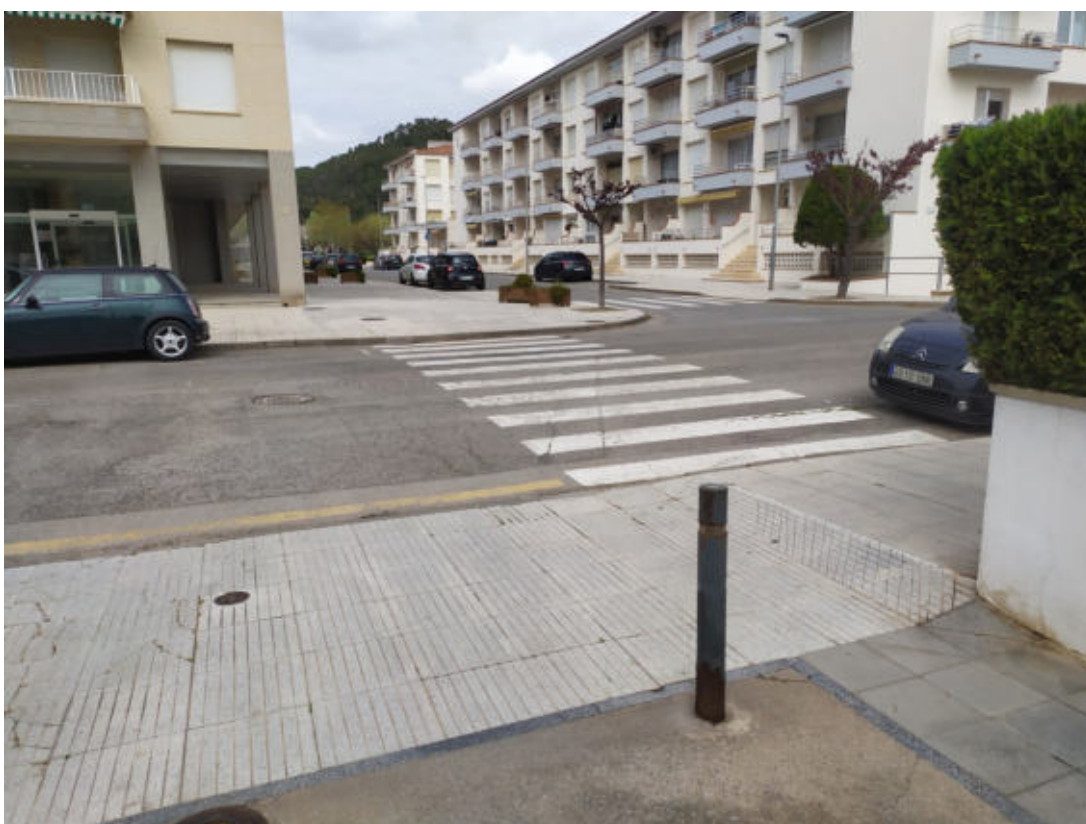
Foto 11: Carrer de la Devesa amb Passatge del Salpatxot. Detall pas de vianants
