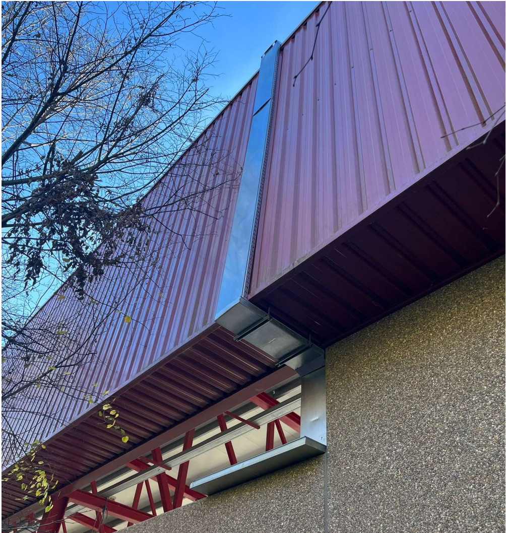
Il·lustració 3. Baixant del tram de CC per la part posterior de l'edifici
