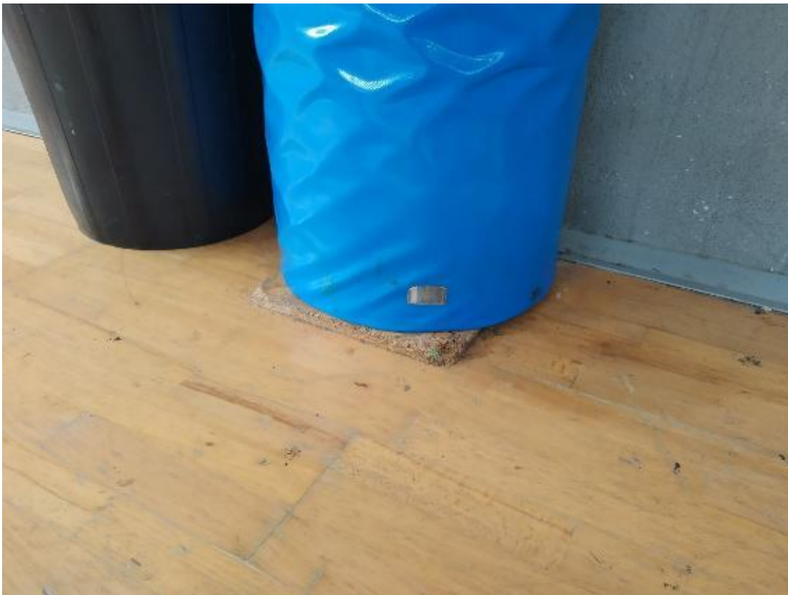
Columnes folrades sobre base de fusta.
