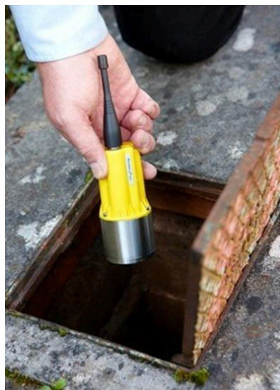
Imatge: instal·lació de sensor Permalog, equip de detecció de soroll
