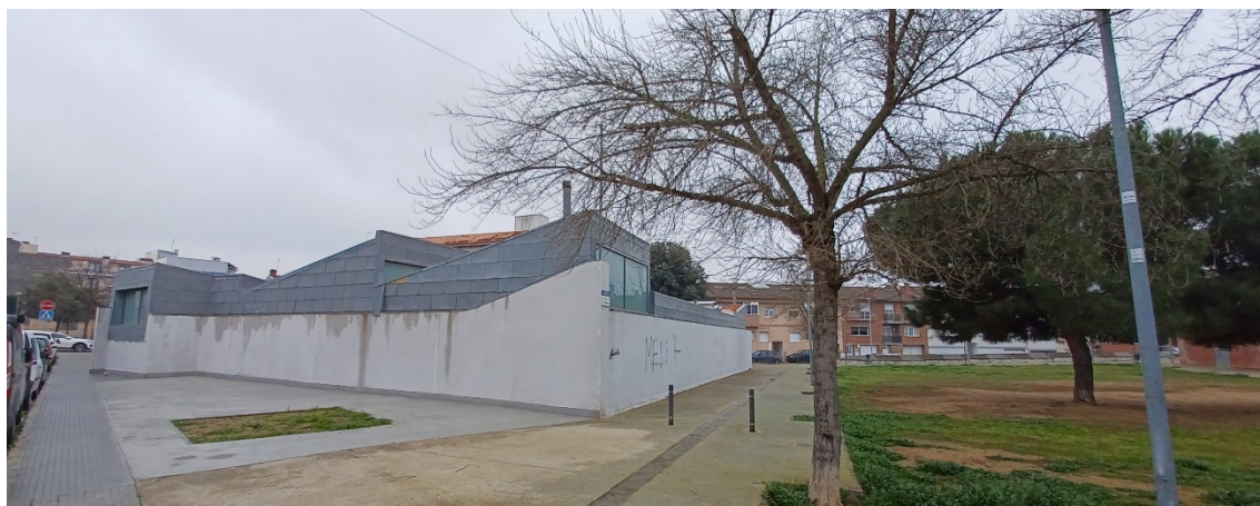
A l'esquerre, espai lliure al nord de l'escola de música, qualificat d'equipament. A la dreta, espai lliure públic darrere l'escola de música, qualificat de sistema de parcs i jardins urbans. Al centre, paviment dur, qualificat en part de sistema viari i en part de sistema de parcs i jardins urbans.
