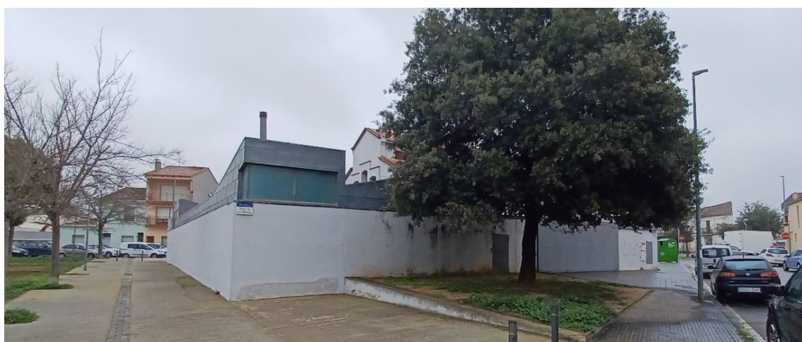
A la dreta, paviment dur, qualificat en part de sistema viari i en part de sistema de parcs i jardins urbans. A l'esquerre, espai lliure al sud de l'escola de música, qualificat d'equipament.
