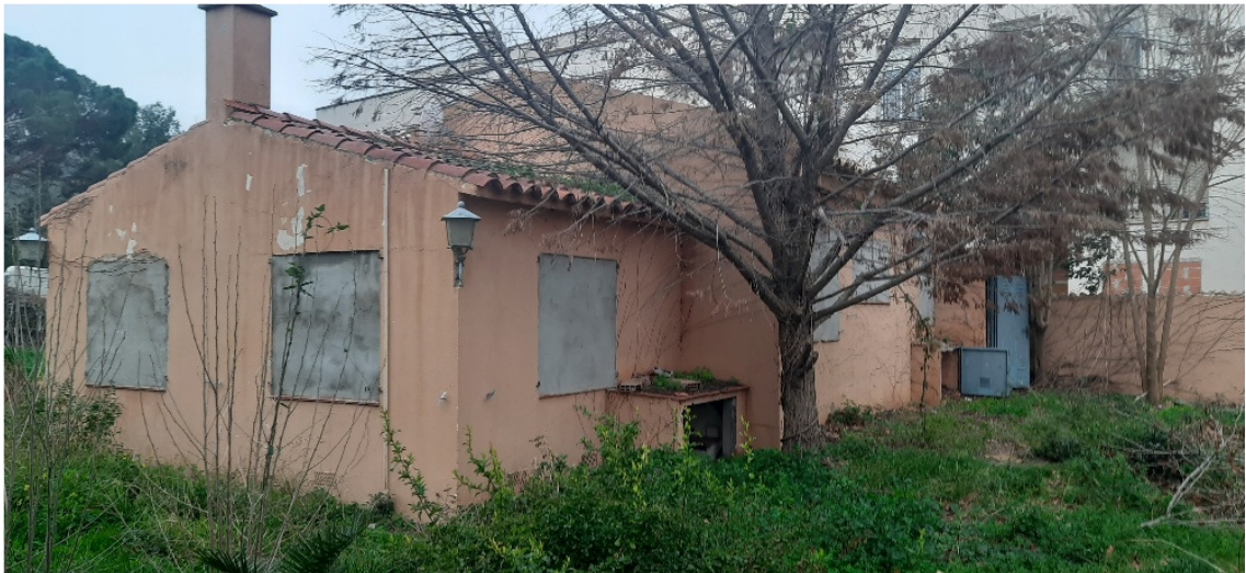
Façana est i nord de l'edificació principal objecte de rehabilitació
