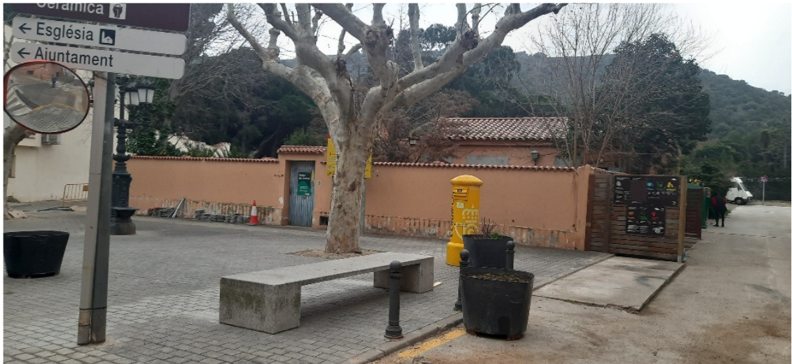
Vista de la finca des de la plaça Javier de Ugarte (Façana nord)
