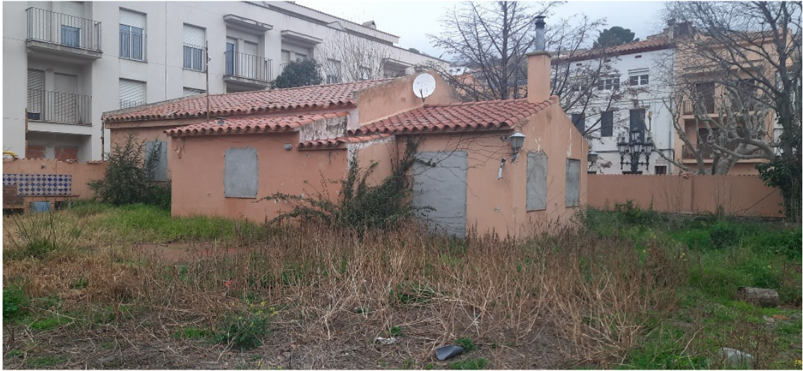
Façana sud i est de l'edificació principal objecte de rehabilitació
