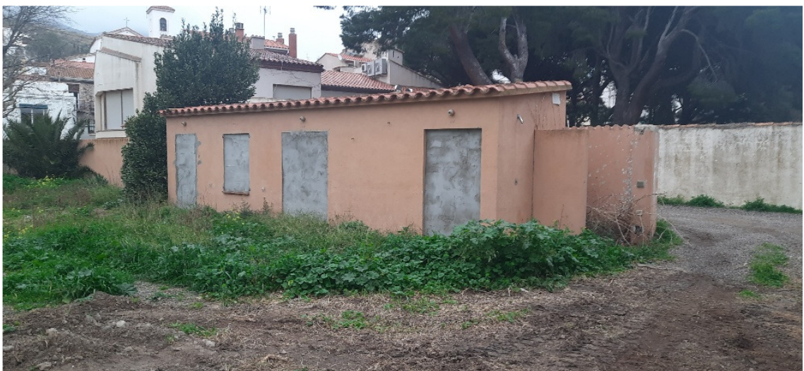
Vista de l'edificació auxiliar
