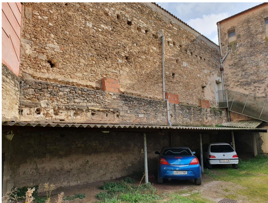
Mur posterior, façana sud
