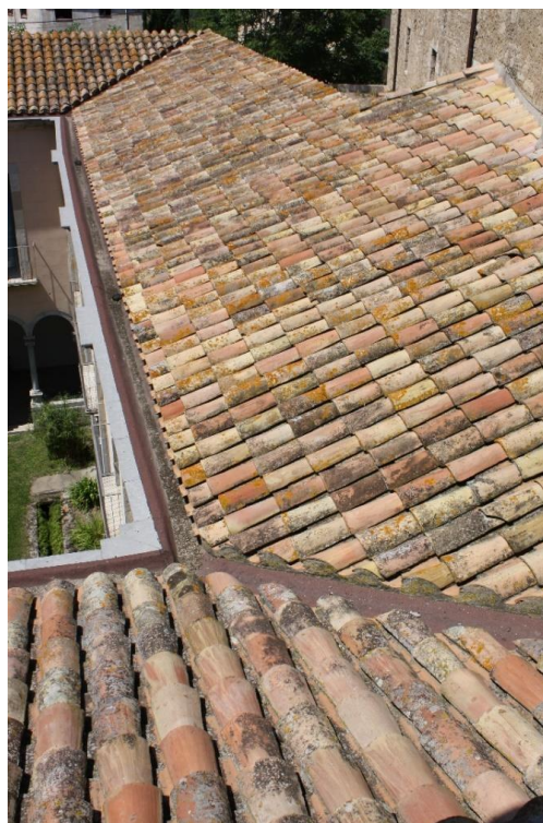
Canal interior de les cobertes del claustre
