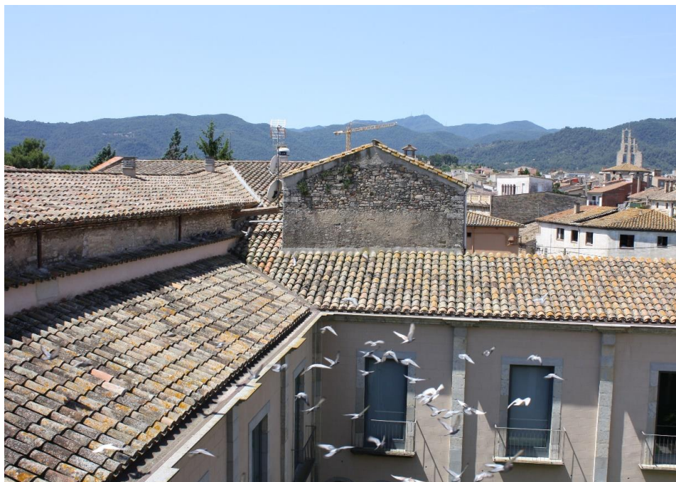
Canal interior cobertes del claustre
